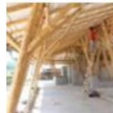
Es un material térmico y aislante acústico ya que en el interior de las cañas de bambú se forman cámaras de aire que regula la temperatura y el sonido.
