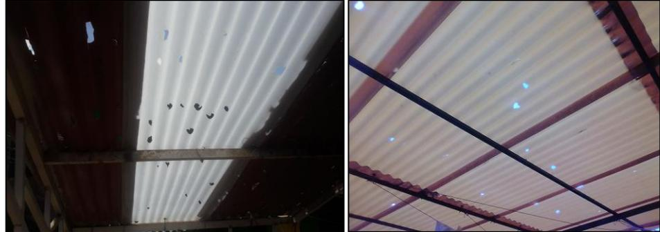
Figura 9: Techos dañados por las fuertes lluvias
