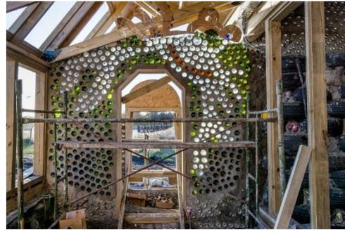
Los muros están levantados con 5.000 botellas de vidrio, 2.000 neumáticos, 2.000m2 de cartón, 14 mil latas.
