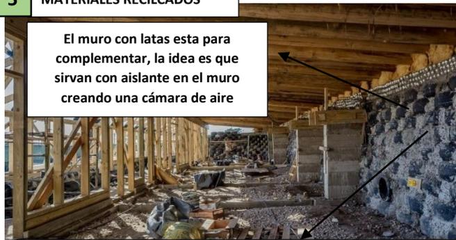
El muro con latas esta para complementar, la idea es que sirvan con aislante en el muro creando una cámara de aire
