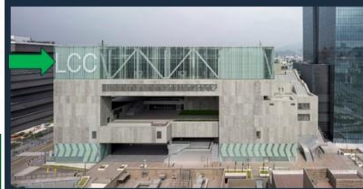
El espacio principal se dispone a manera de paralelepípedo en la penúltima planta, resaltando su jerarquía con un cambio de color y una textura distinta a la del edificio conjunto. La doble altura y la cima en la que se le dispone llega a ser predominante para un espacio de tal magnitud.
