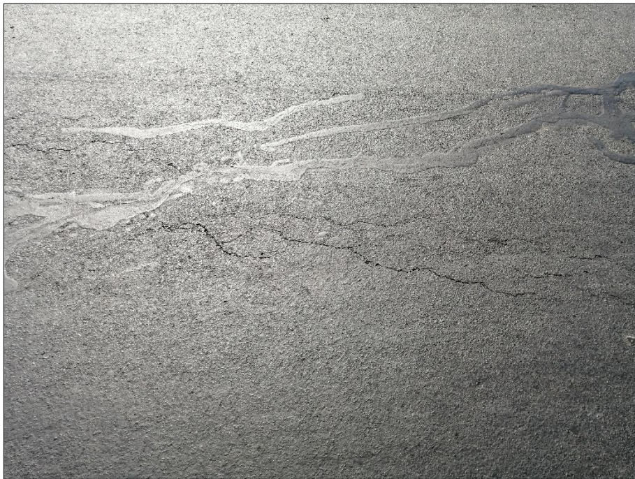
Figura 35. Fisuras Transversales
