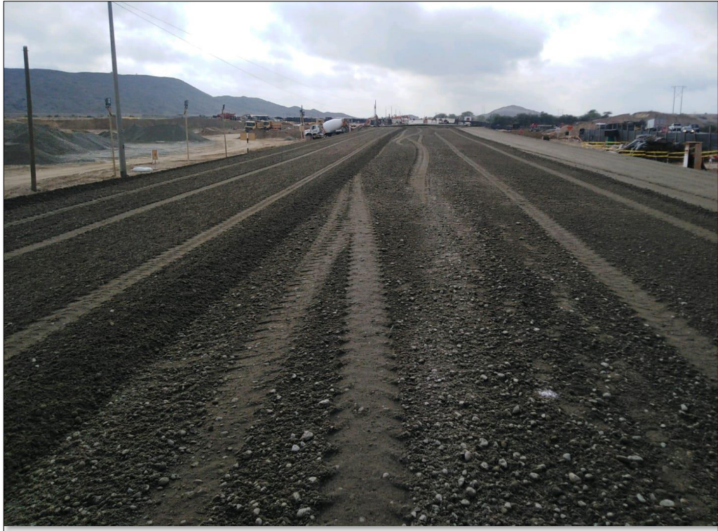
Figura 4. Tendido y preparación de Base
