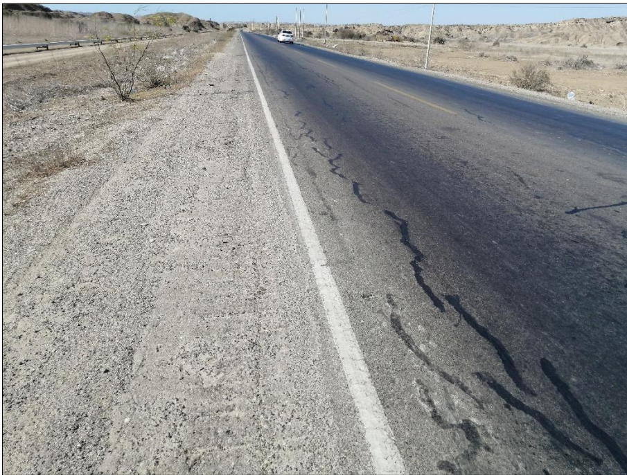
Figura 29. Grietas longitudinales
