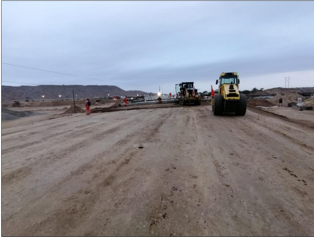
Figura 3. Preparación de SubBase
