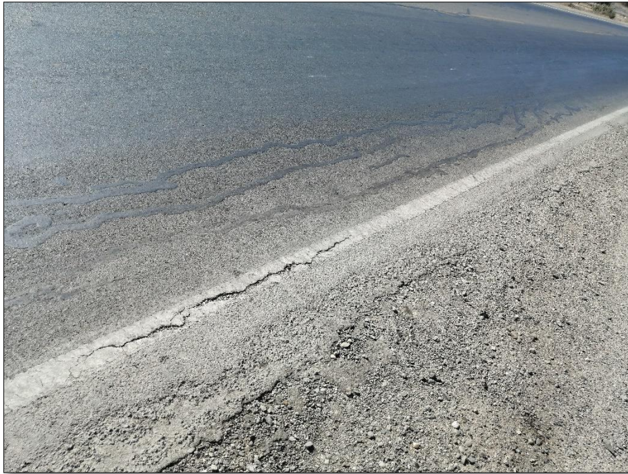
Figura 34. Fisuras longitudinales
