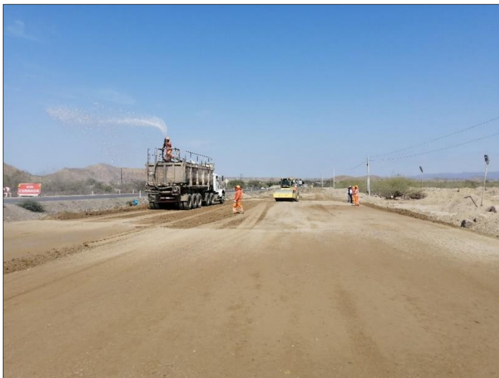
Figura 2. : Preparación de Subrasante.
