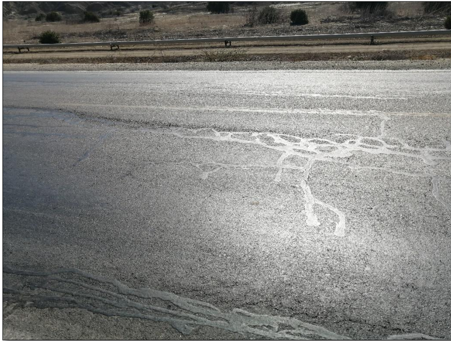
Figura 36. Ahuellamiento – Hundimiento - exudación
