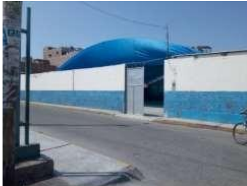
Figura 13. Vista fachada del local de danza de la ESAD Virgilio Rodríguez Nache Fuente: Elaboración propia
