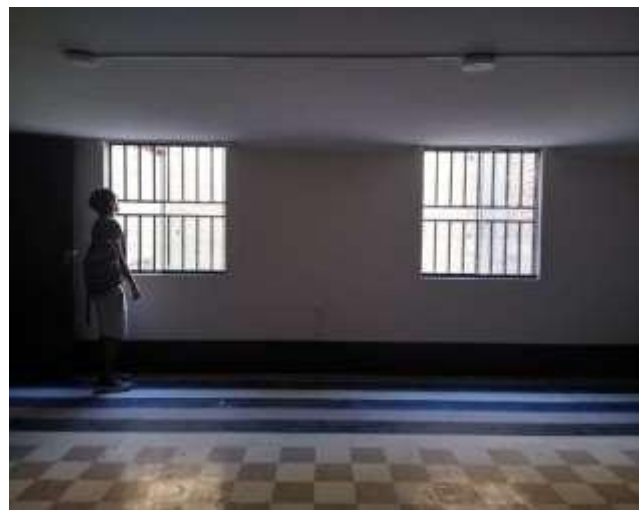
Figura 10. Salón de práctica con piso de cerámica e insuficiente ventilación Fuente: Elaboración propia
