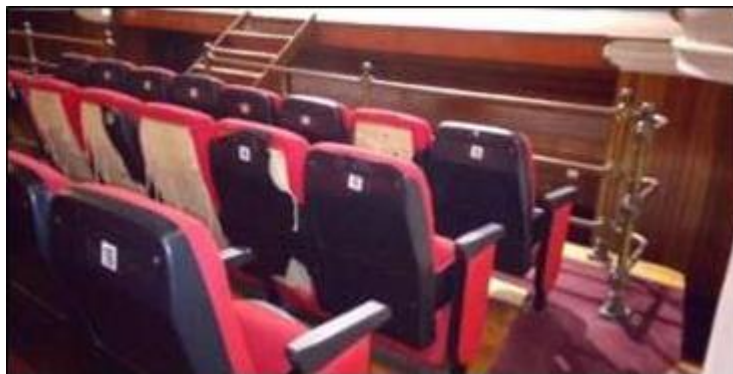
Figura 20. Butacas en mal estado del Teatro Municipal
