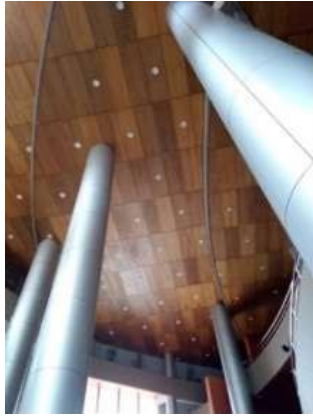
Figura 27. Imponente infraestructura en columnas y buenos acabados Fuente: Elaboración propia
