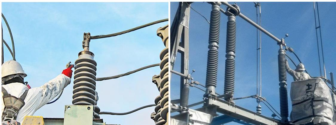
*Figura N° 3: Aplicación de recubrimiento dieléctrico para aisladores de AT. Fuente Midsun 570™ HVIC*
