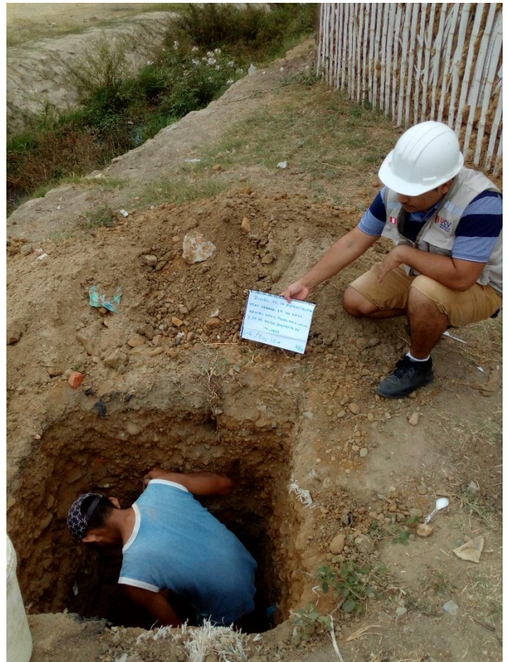
Foto N° 6 Calicata N° 03 – Calle Pedro Ruiz Gallo
