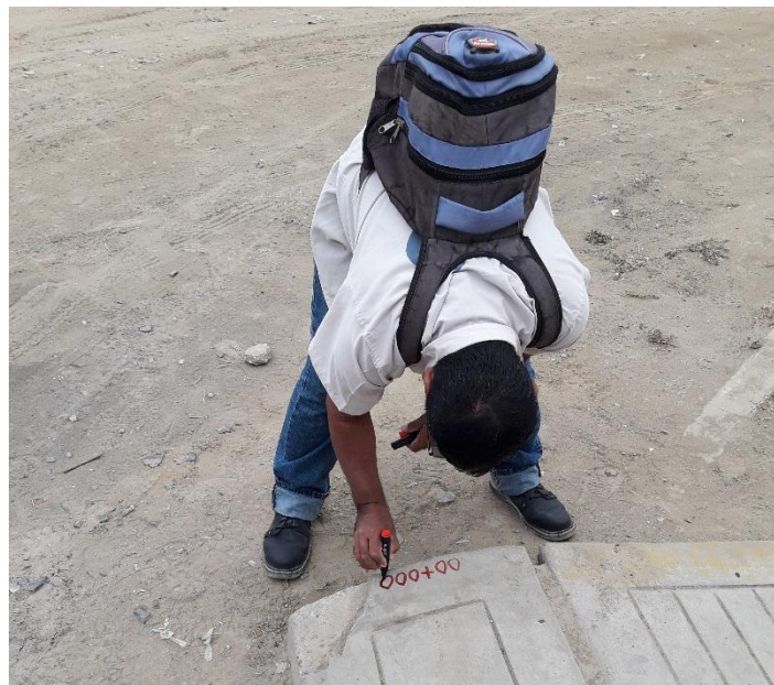
Foto N° 2 Colocación de progresivas para levantamiento topográfico
