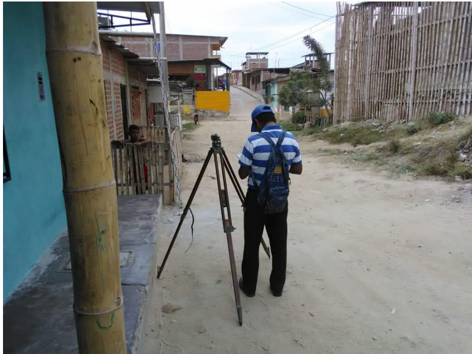
Foto N° 4 Levantamiento topográfico Calle Angamos
