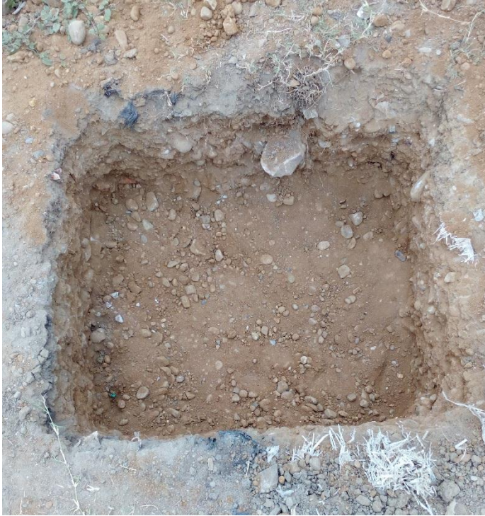
Foto N° 5 Inicio de excavación para calicatas
