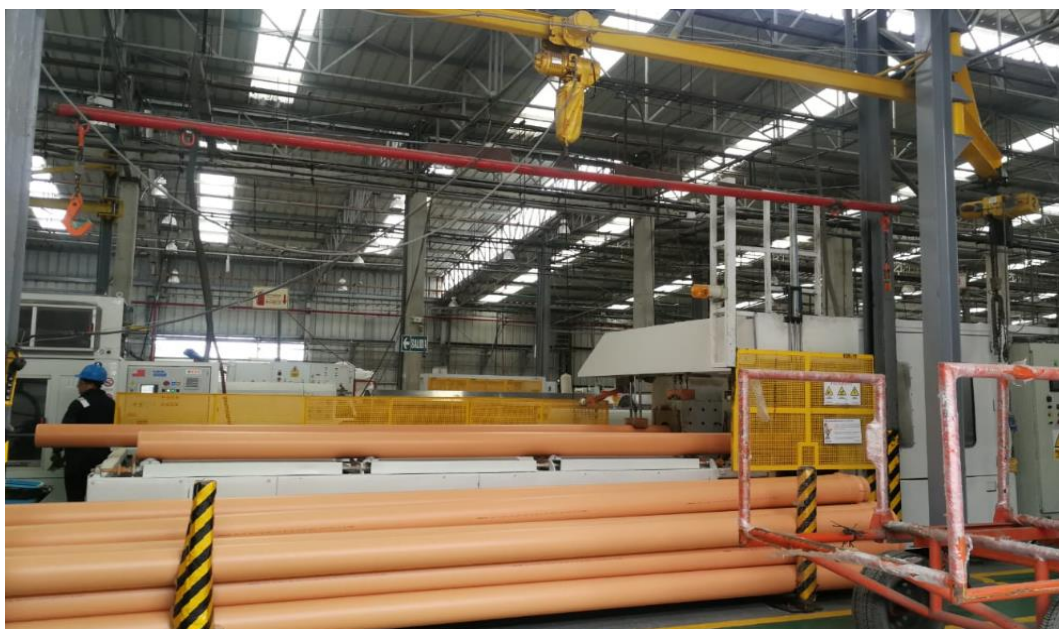
Figura 24. Eliminación de fugas de aire.
