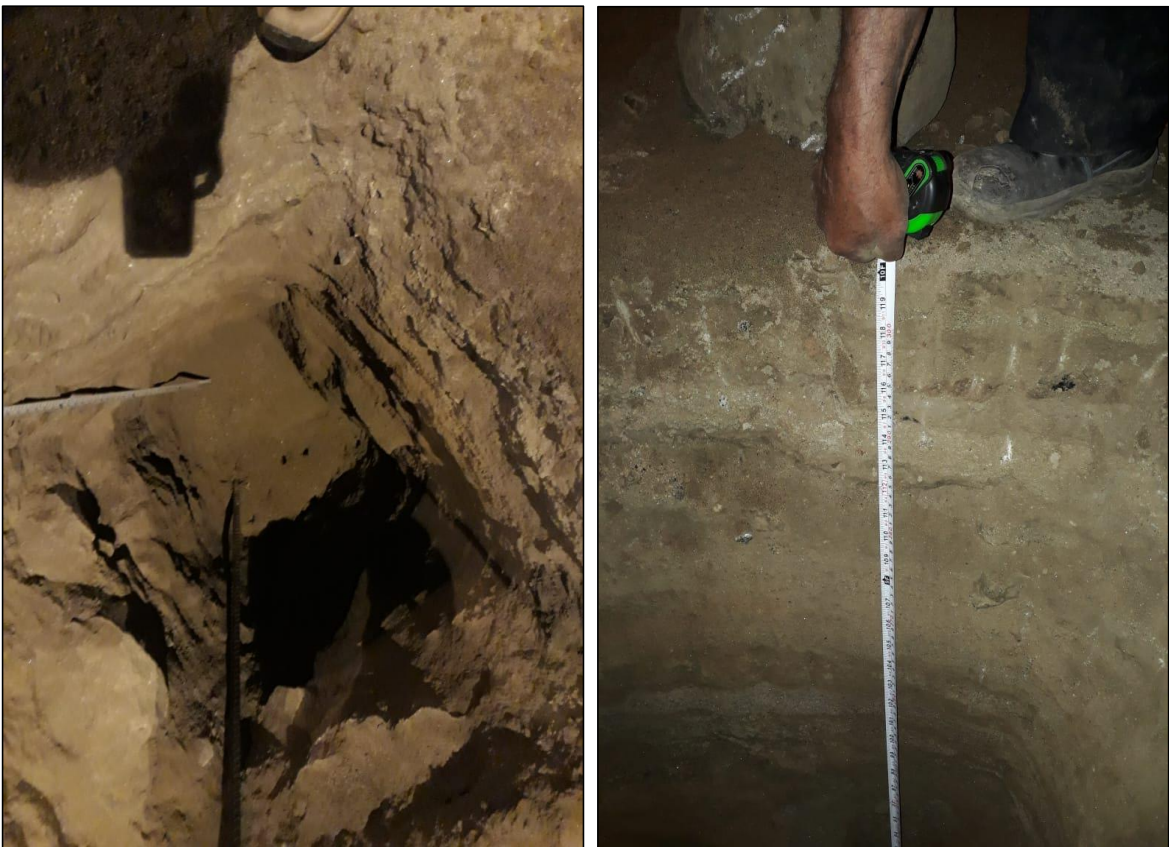
Fotografía 6. Excavación de la calicata N°3 realizada a la vivienda
