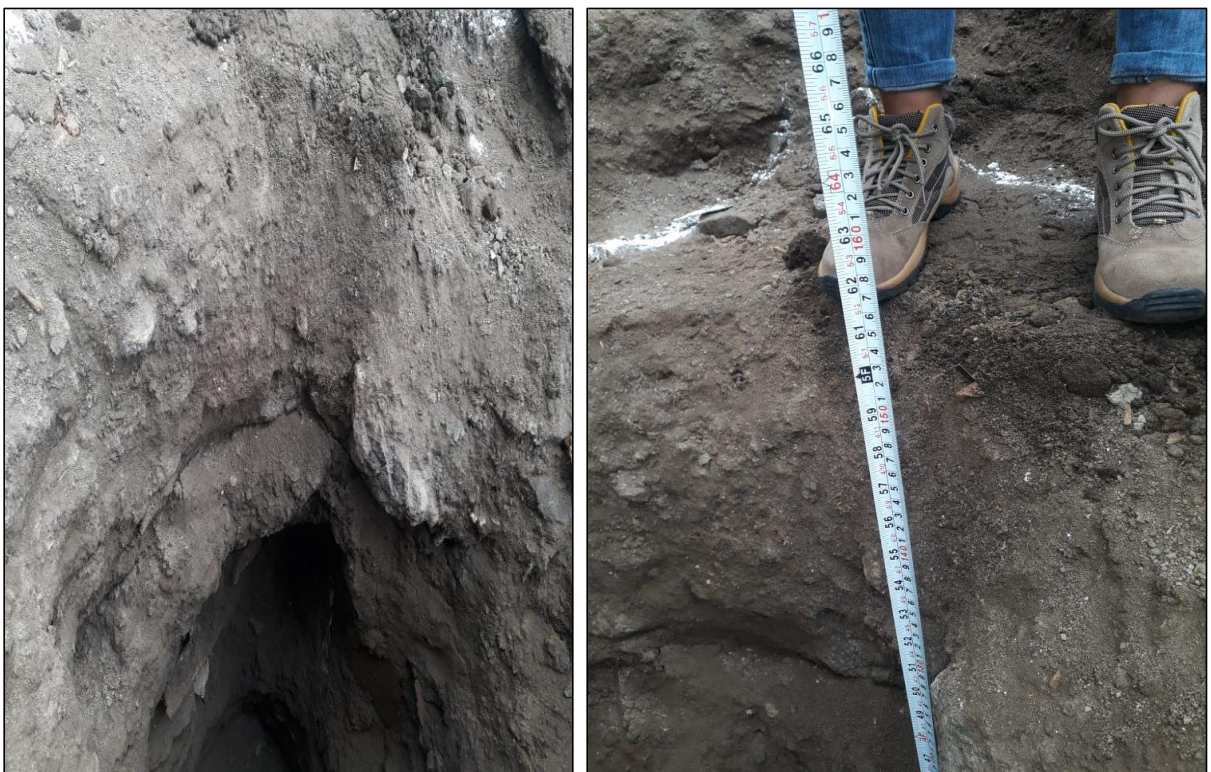
Fotografía 2. Excavación de la calicata N°1 realizada a la vivienda
