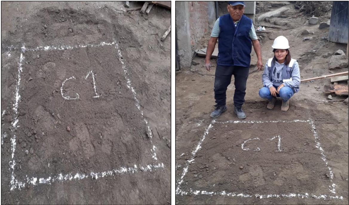
Fotografía 1. Calicata N°1 realizada a la vivienda
