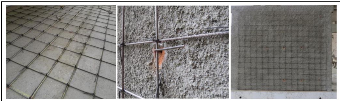
Figura 54. Técnica para reforzar muros de albañilería
