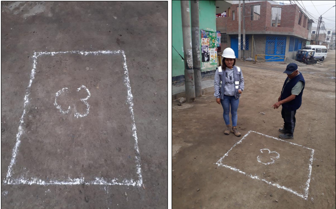
Fotografía 5. Calicata N°3 realizada a la vivienda
