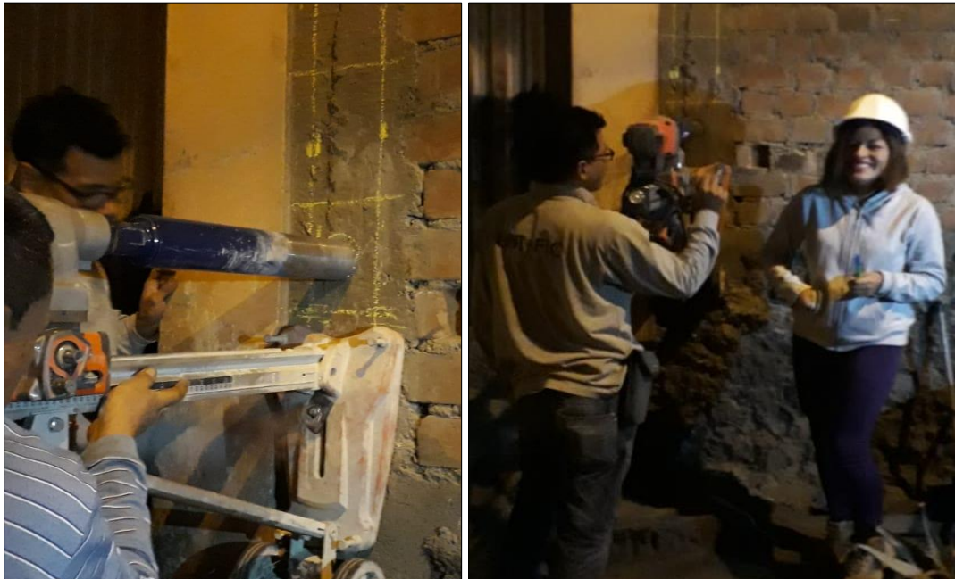
Figura 27. Preparación de la superficie para la extracción de muestra
