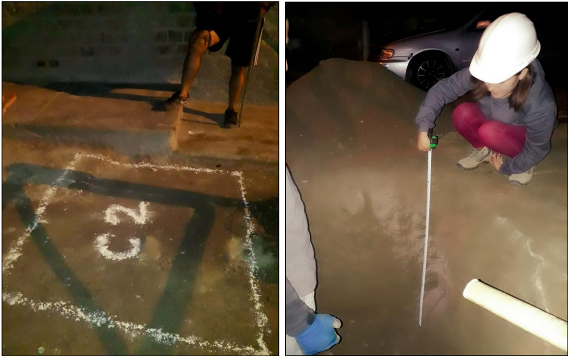
Fotografía 4. Excavación de la calicata N°2 realizada a la vivienda
