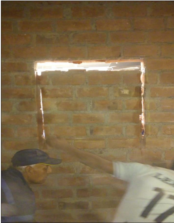
Fotografía 7. Extracción y traslado del murete de la vivienda
