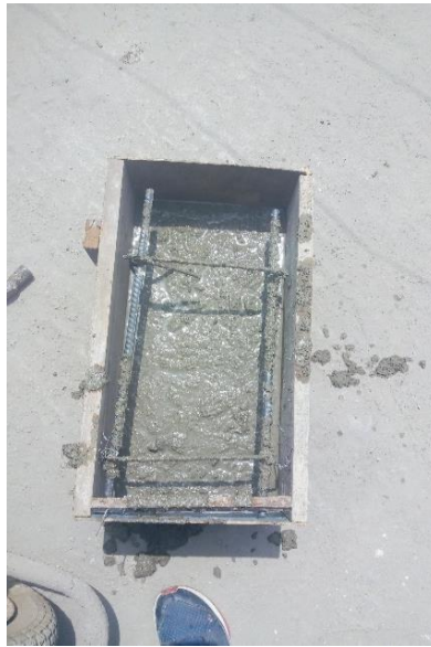
Figura 10. Armado de viga
