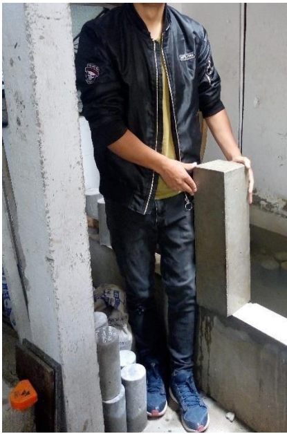
Figura 6 curado de vigas
