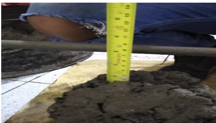
Imagen 18: Prueba de SLUMP
