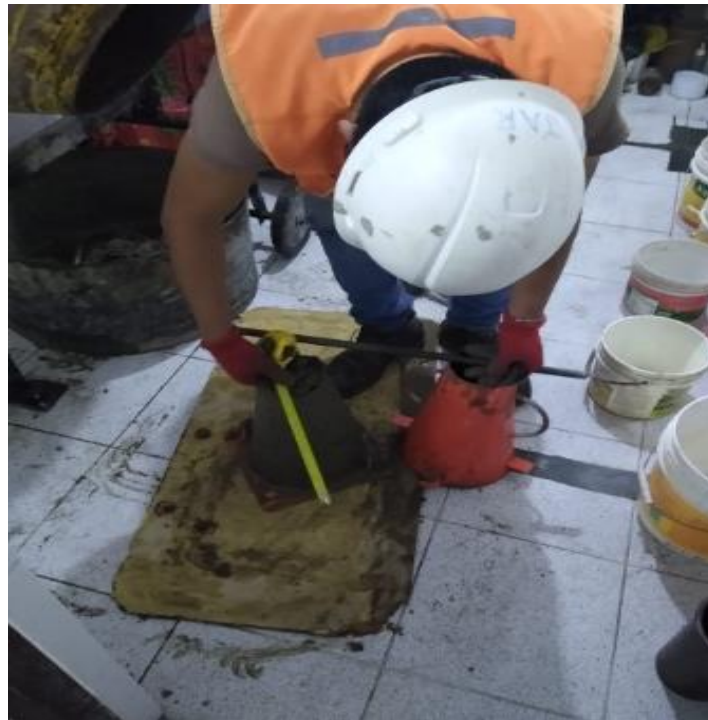
Figura 16: Prueba de slump.
