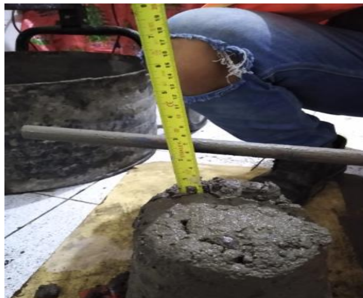
Figura 15: Prueba de slump.
