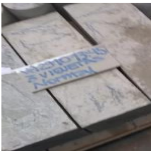
Figura 23: Desencofrado de viguetas
