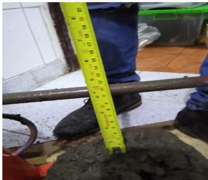
Figura 13: Prueba de slump.
