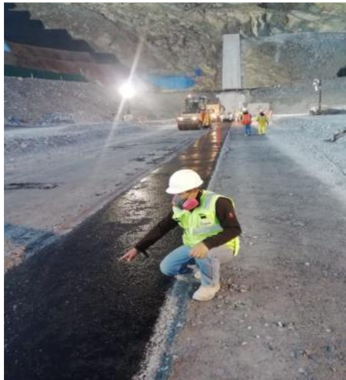
Figura N°08 Medición del espesor capas del asfalto final
