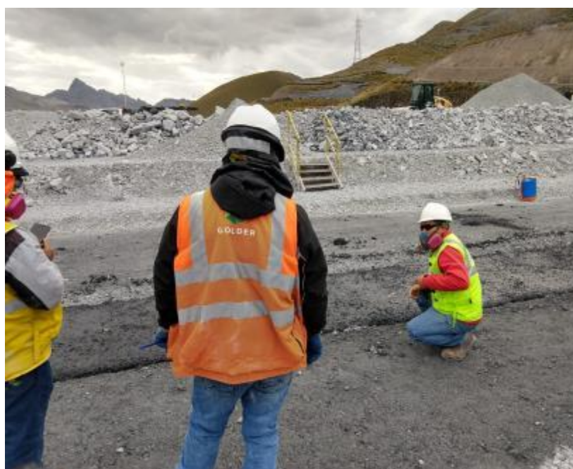
Figura N°03 Medición de la temperatura del Asfalto para el compactado
