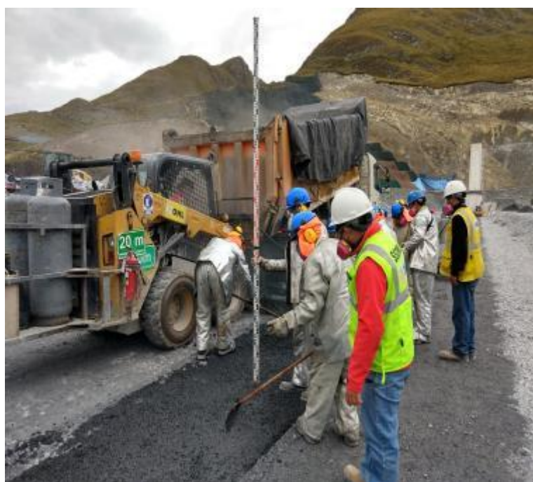
Figura N°05 Medición del espesor de capas con nivel ingeniería
