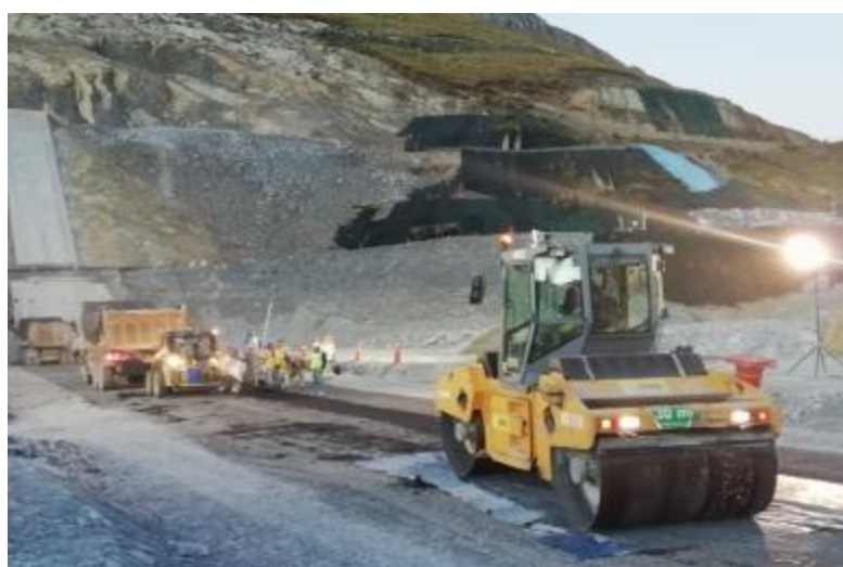
Figura N°06 Compactación de asfalto con rodillo tandem 9 Tn
