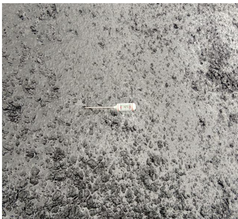
Figura N°04 Medición de la temperatura del Asfalto con el equipo
