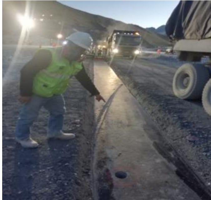
Figura N°07 Retira muestra de asfalto para determinar el porcentaje de vacíos
