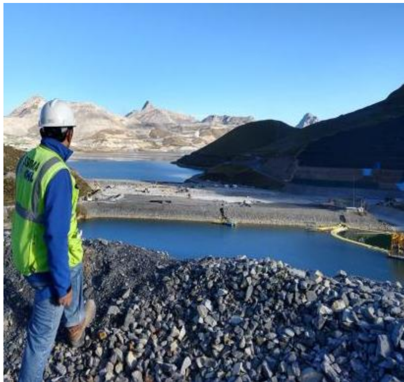
Figura N°02 Vista Panogramica de la presa Polishing Pond
