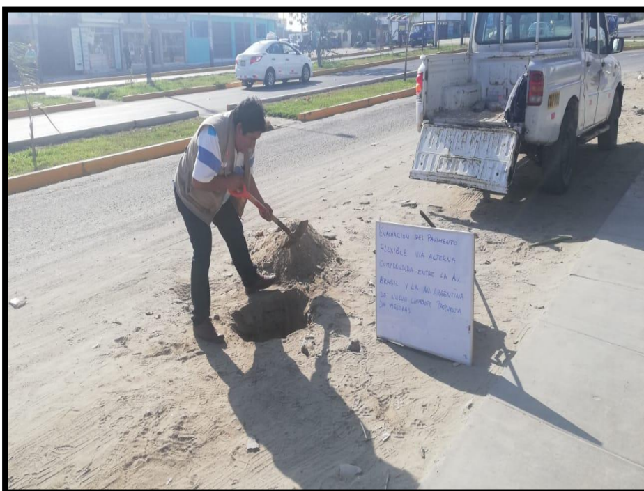
IMAGEN Nº12: Excavación para el perfil estratigráfico a 1.5 m de profundidad
