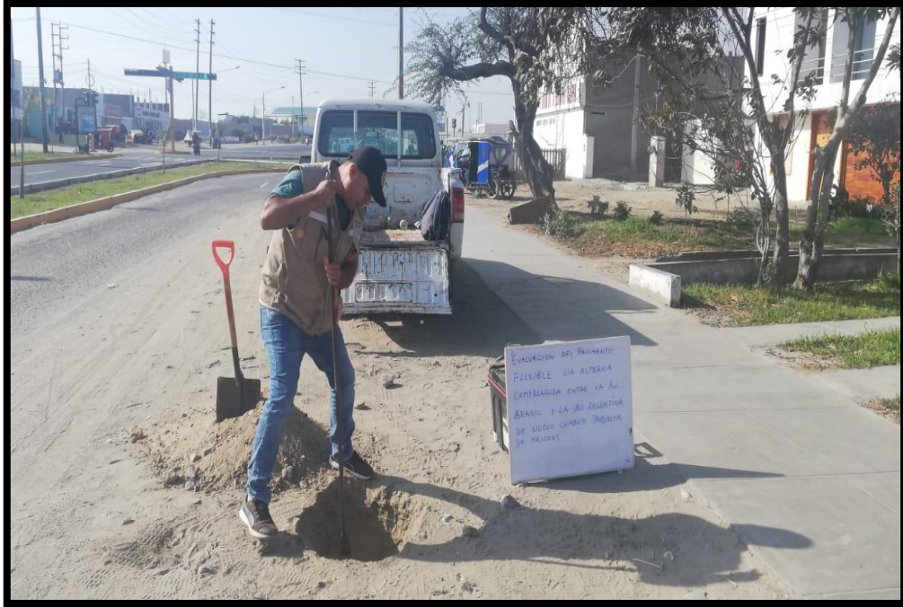
IMAGEN N°15: Excavación para el perfil estratigráfico a 1.5 m de profundidad
