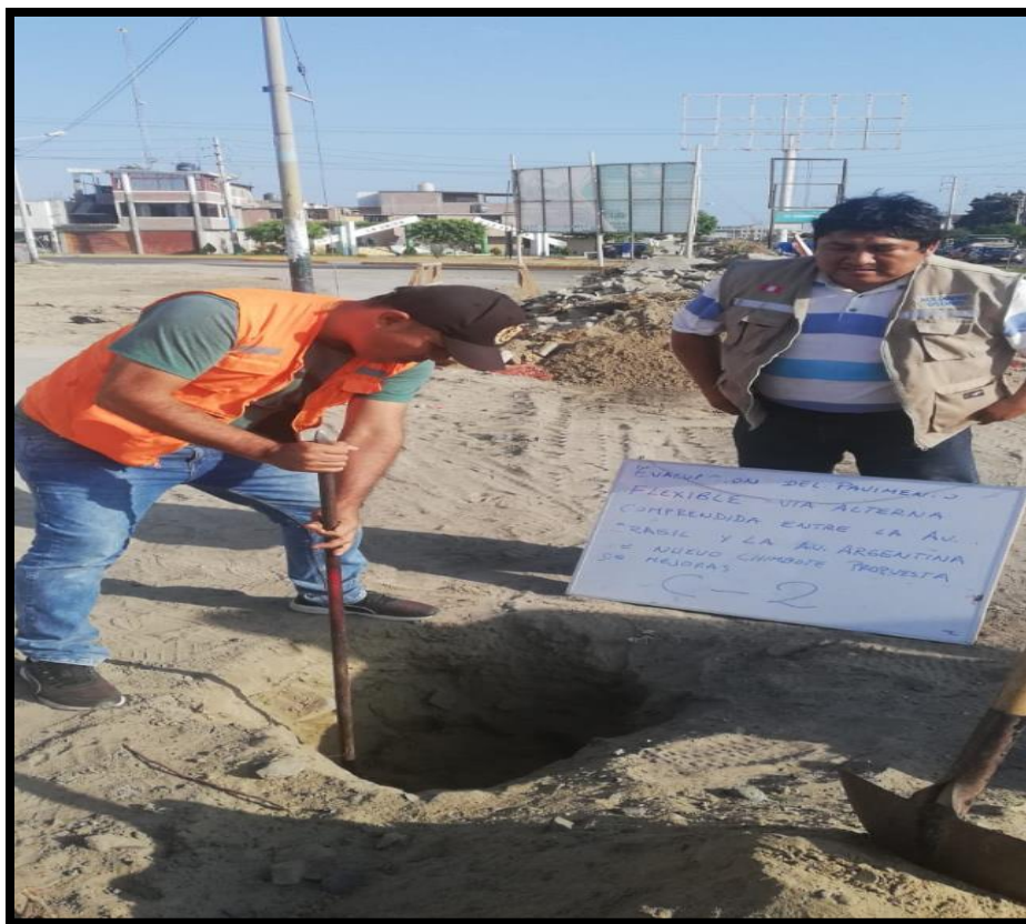
IMAGEN Nº11: Excavación para el perfil estratigráfico a 1.5 m de profundidad
