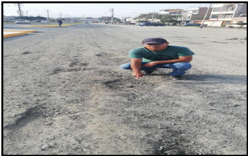
IMAGEN N°2: Reconocimiento de campo y perforación de calicata
