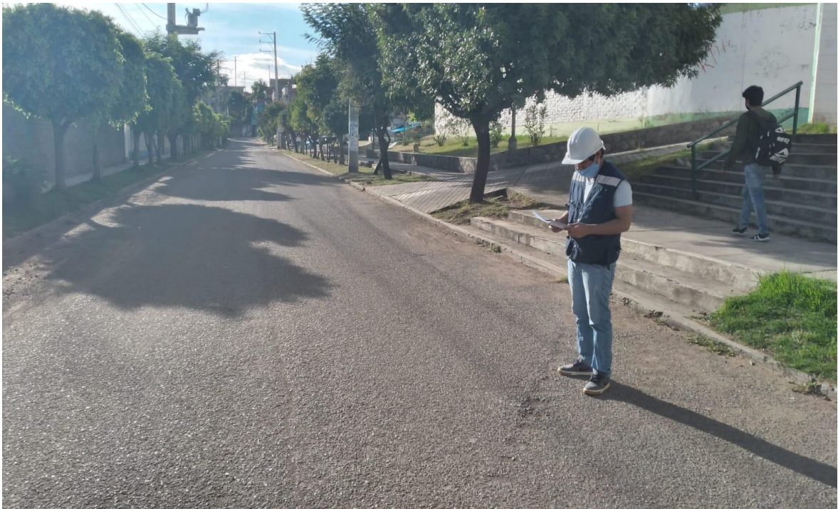
Evaluación superficial del pavimento flexible con el método PCI
