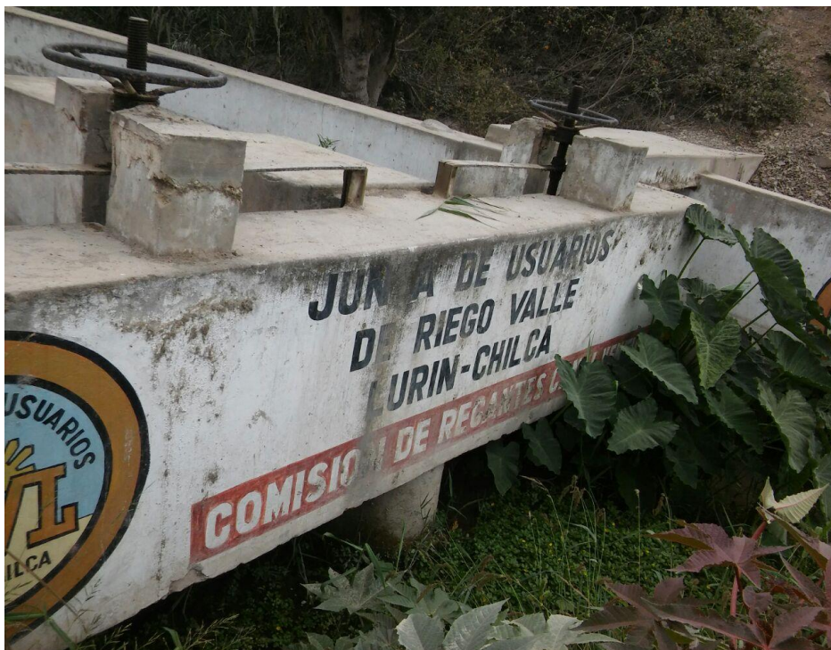
Figura 63: Maleza y falta de mantenimiento en la bocatoma
