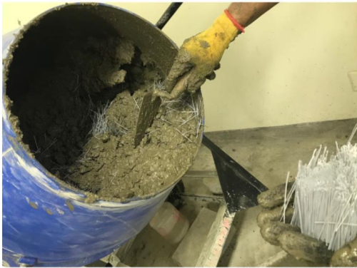
Figura 24. Incorporación de la fibra sintética en la mezcla de concreto.
