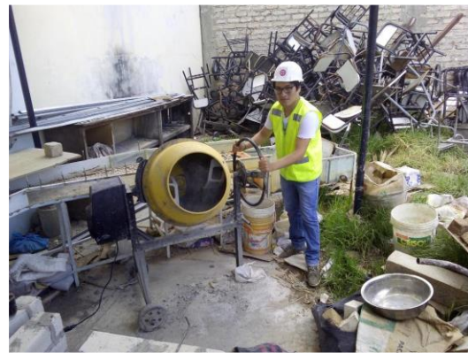
Imagen 2. Mezcla del concreto
