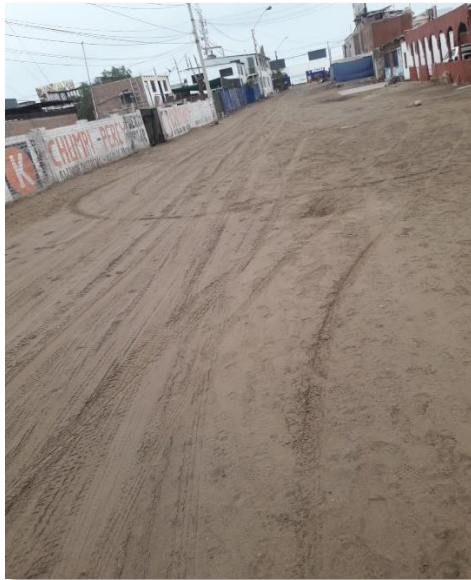
Figura 1. Calle sin pavimentar
