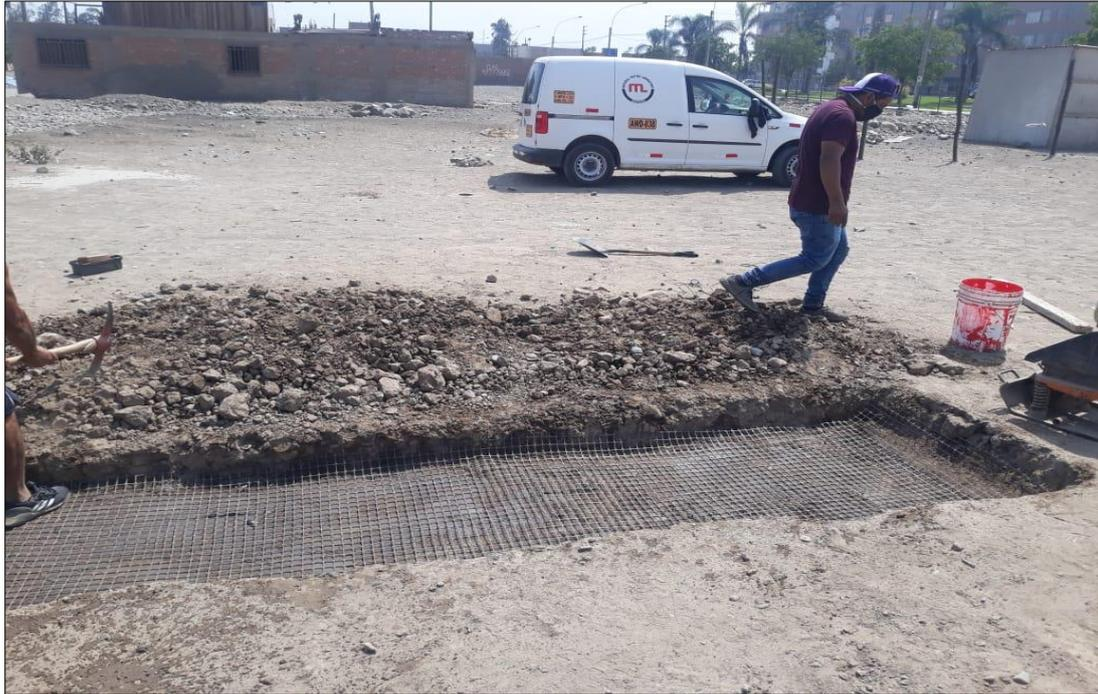
Preparación del terreno con adición de “Geomallas Multiaxiales”
