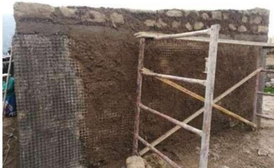
MÓDULO PRUEBA CON GEOMALLA LATERAL 2
