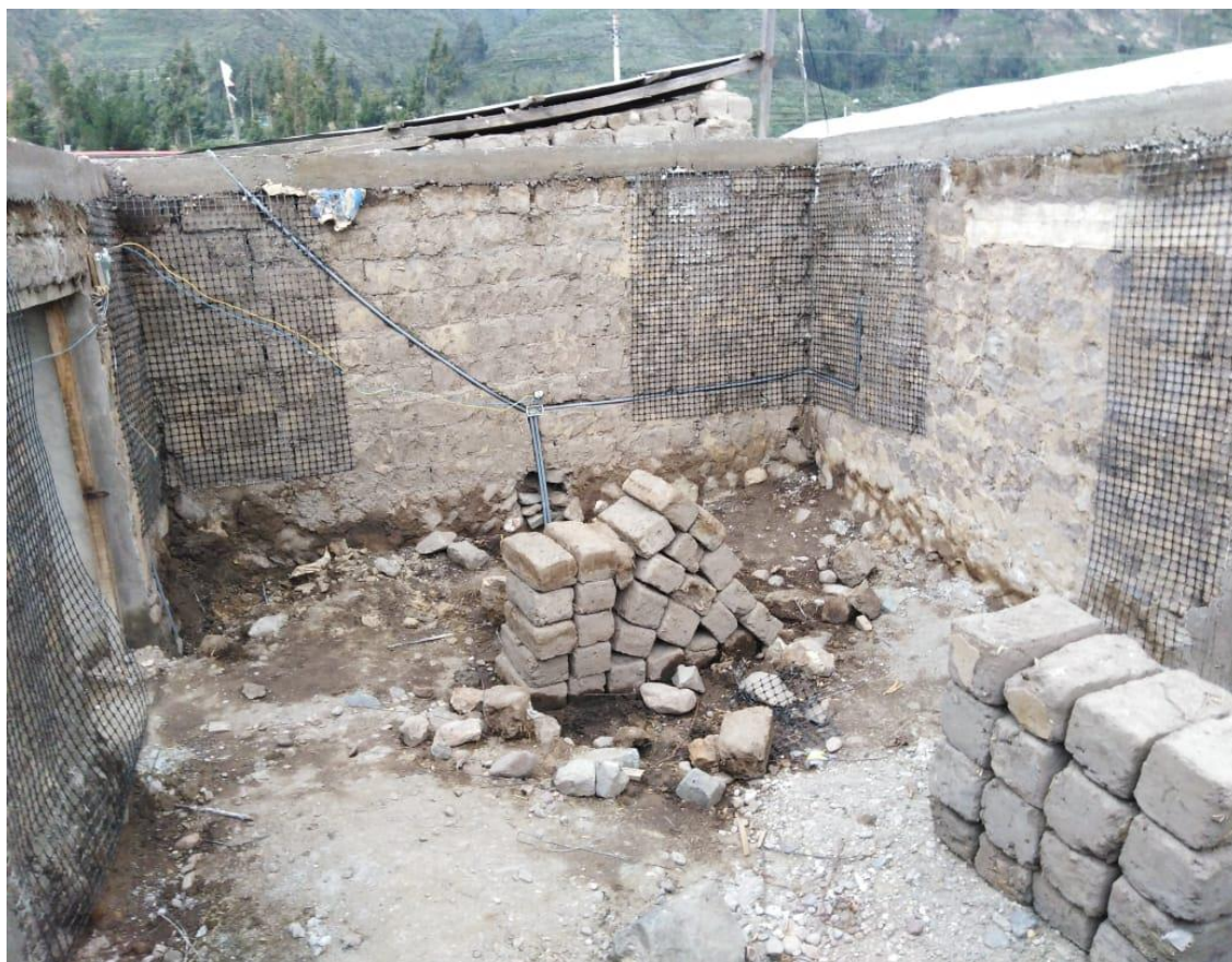
VIVIENDA CON REFORZAMIENTO CON GEOMALLA
