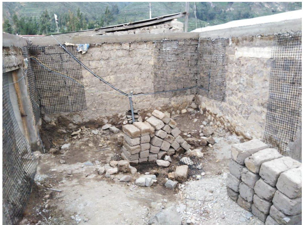
REFORZAMIENTO DE MURO
