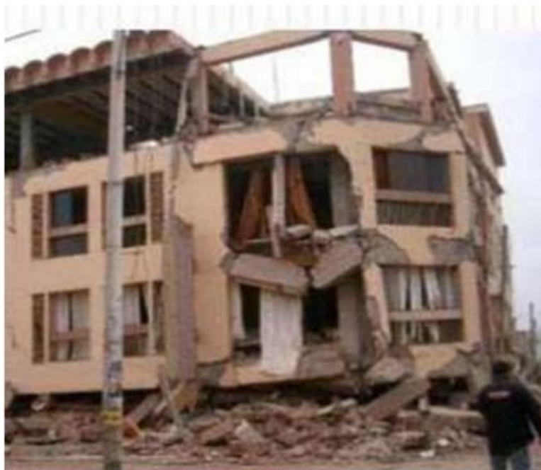
TERREMOTO DE MOQUEGUA 2001
