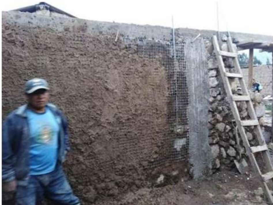
MÓDULO PRUEBA CON GEOMALLA LATERAL 1
