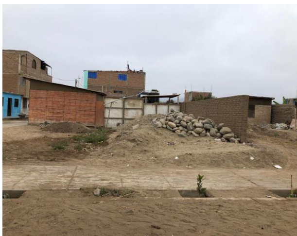
Viviendas en reconstrucción después del Fenómeno de El Niño Costero 2017- Centro Poblado de California – Virú.
