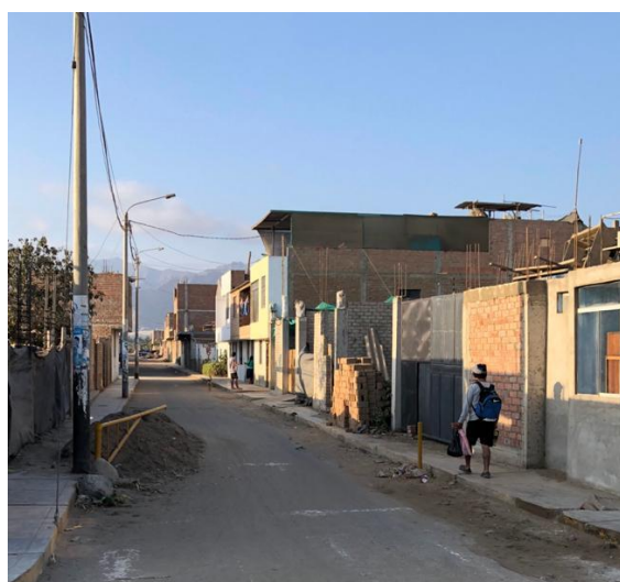
Reconstrucción de la calle Diego de Almagro del Centro Poblado de California - Virú después del Fenómeno de El Niño Costero 2017
