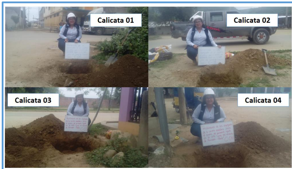
Figura 100. Caicatas en la Calle Lima del distrito de Morropón – Piura, 2019.
