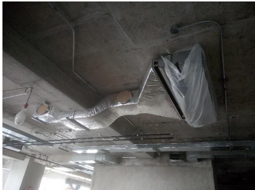
Figura 48: Instalación de ductos para fan coil - Surco
