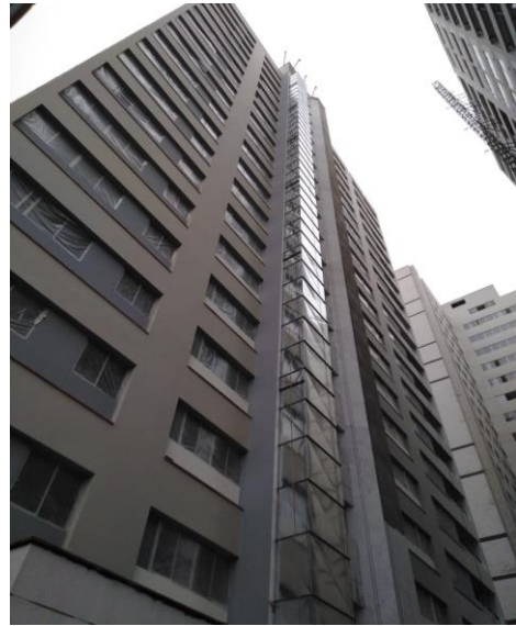
Figura 50: Instalación de ductos – Lince
