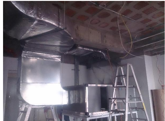
Figura 45: Instalación de ductos para UMA – La Molina
