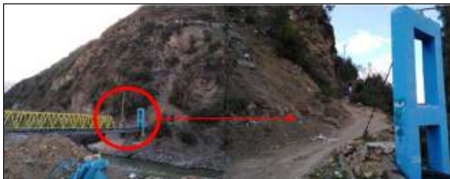
Ilustración 11: Ingreso peatonal al sector de Chaulla
