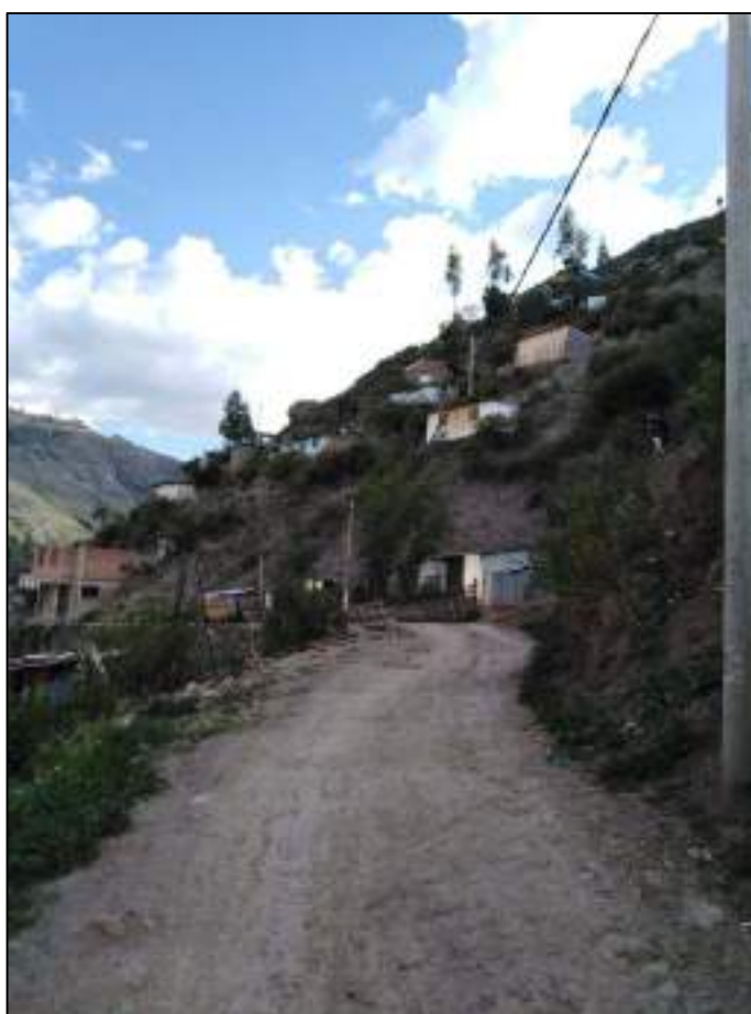
Ilustración 3: Viviendas del sector de Chaulla ubicados en la ladera
