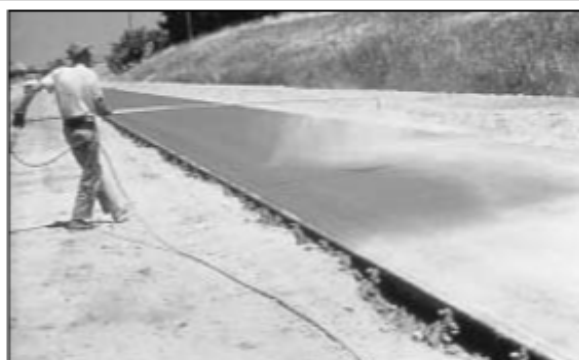
Aplicación de un compuesto formador de membrana ( curador ) con aspersor manual.
