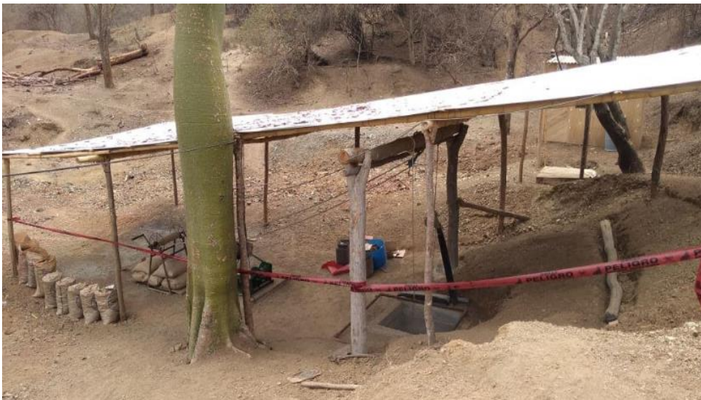
Figura N°16. Instalaciones de la mina Cuchi Corral. Fuente. Propia del autor
