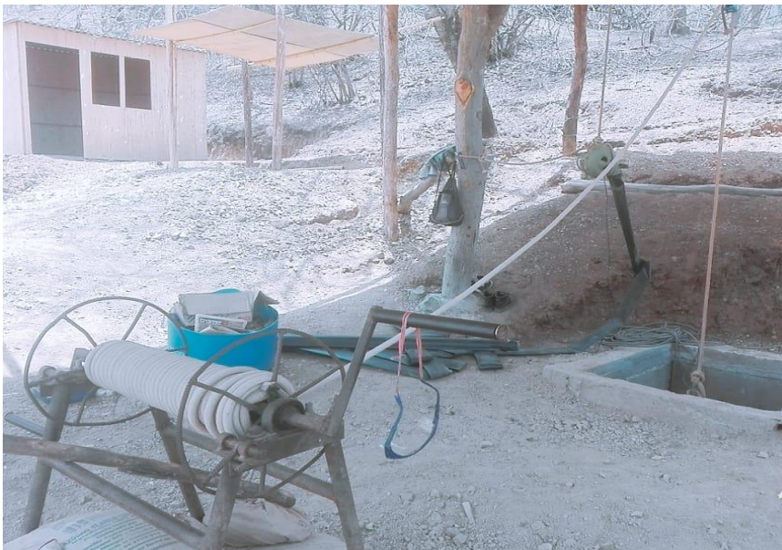
Figura N°07. Instalaciones de winche – Mina Cuchi Corral. Fuente: propia del autor.
