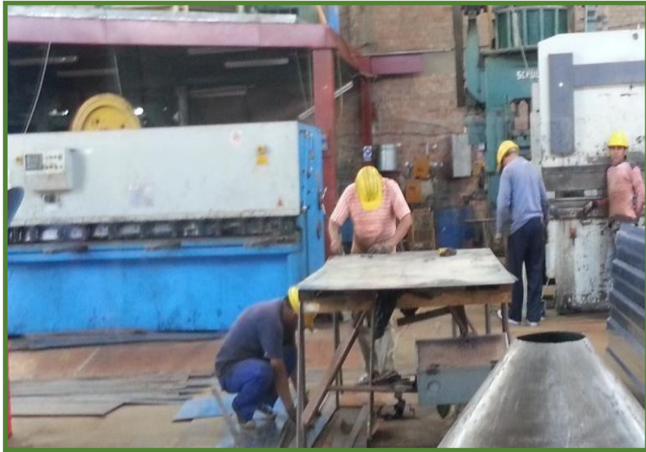
Figura 13. La falta de orden y falta de epp's (guantes y zapatos) en el lugar de trabajo Fuente: Elaboración propia
