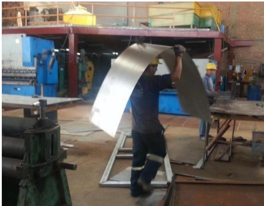
Figura 7. Levantamientos de planchas metálicas sin protección.
