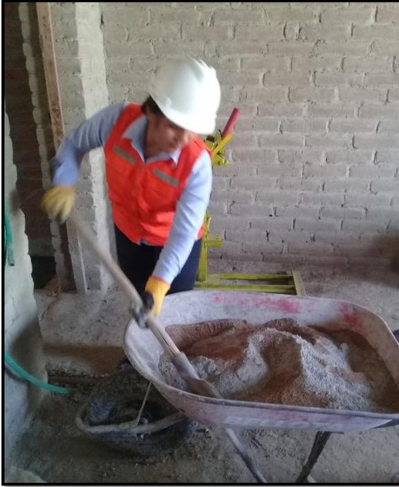
**Figura 03.18.** Mezclado de materiales (suelo – cemento).
