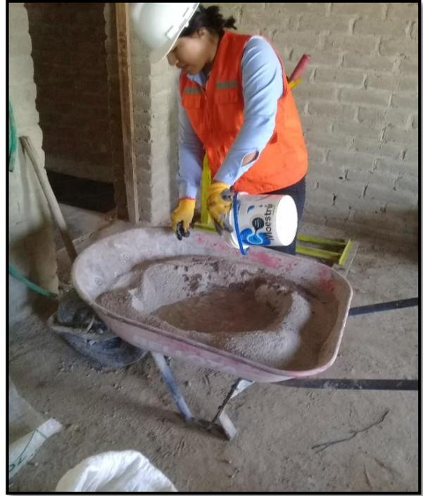
**Figura 03.19.** Adición de agua a la mezcla.
