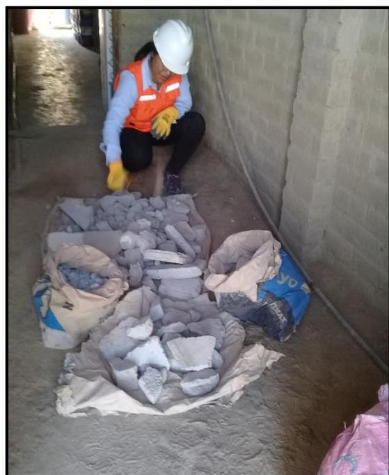
**Figura 03.13.** Trituración de residuos de concreto de forma manual.
