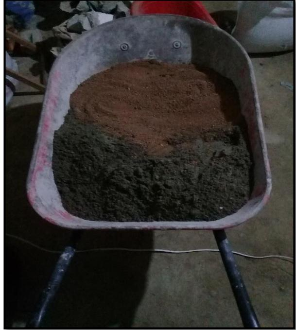
**Figura 03.18.** Materiales listos para mezclar en seco. (Suelo + arena)
