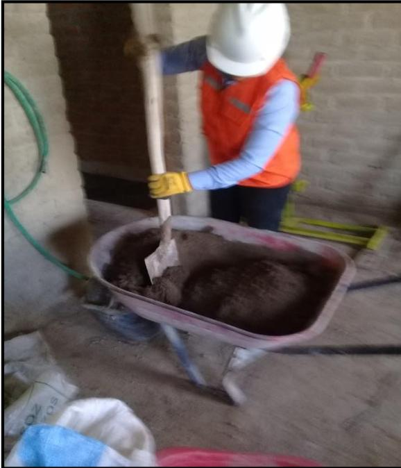
**Figura 03.20.** Mezclado con agua, verificando la humedad óptima.
