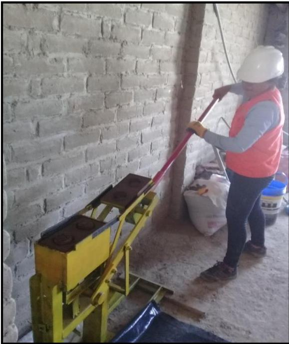
**Figura 03.24.** Desmoldado del bloque.
