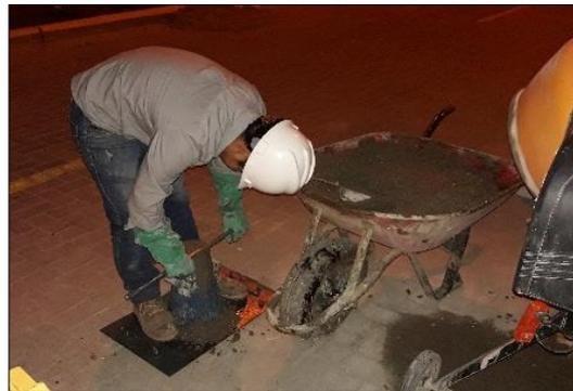
Imagen 45: Concreto con fibras plásticas PET
