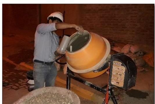
Imagen 43: Colocación de PET en el concreto
