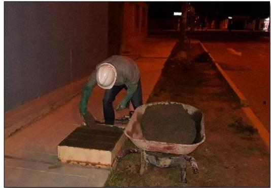
Imagen 52: Llenado y varillado del concreto
