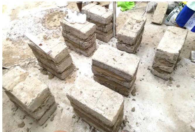
Figura 48: Repetimos el proceso al resto de las pilas de adobe
