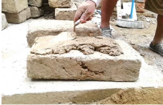
Figura 46: Asentado de 2cm de mortero
