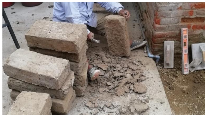
Figura 42: Limpieza y eliminación de exceso de tierra de los bloques de adobe
