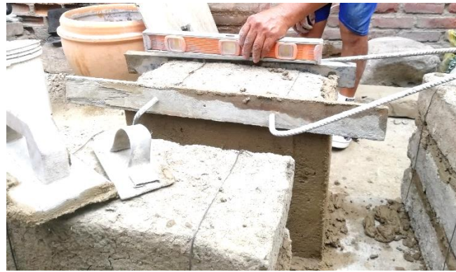
Figura 50: Utilizamos un nivel para dar un mejor acabado
