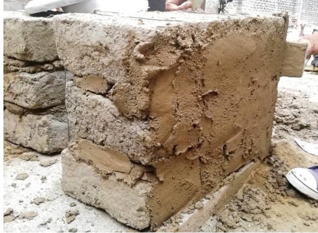
Figura 49: Continuamos con el empastado de las pilas de adobe
