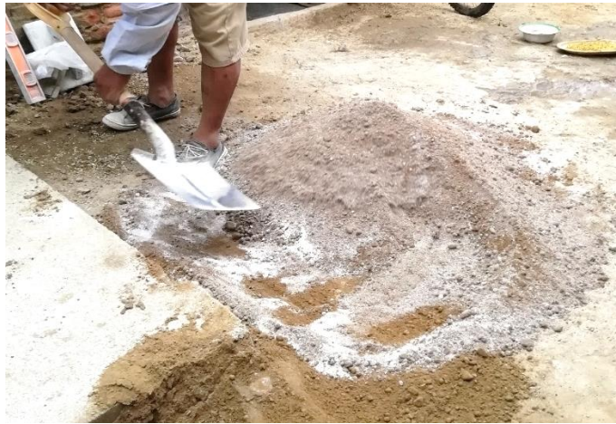
Figura 44: Mezclamos de manera uniforme el material
