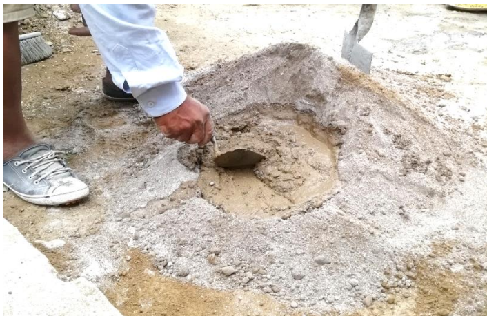
Figura 45: Añadimos agua a la mezcla para el asentado
