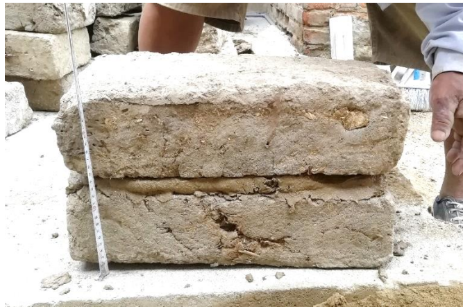
Figura 47: Verificamos que quede centrado y con altura ideal
