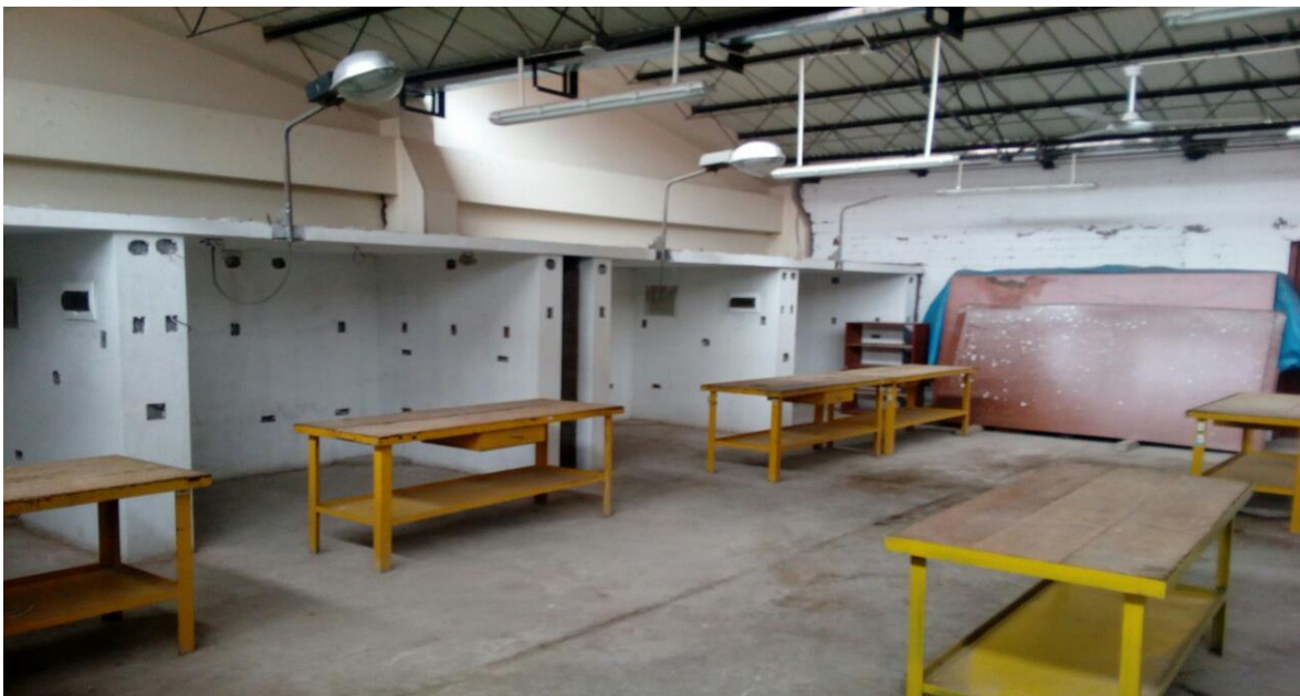
Figura 16. Áreas de soldadura e instalaciones eléctricas para el taller de los alumnos en la Institución Técnica Sencico.
