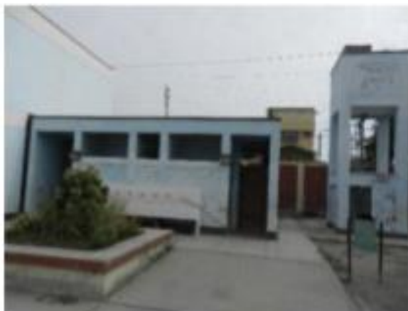
Figura: Estado actual de los servicios higiénicos Fuente: Propia (2019).
