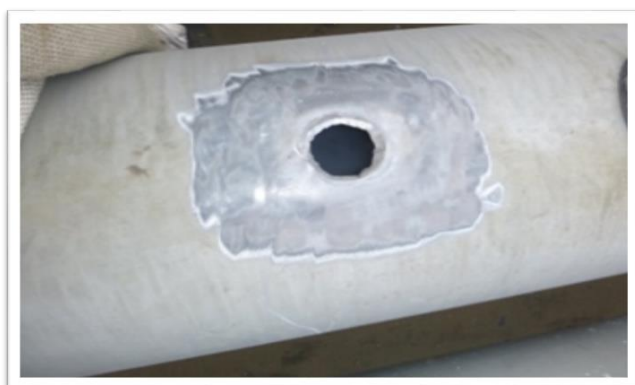
FIGURA 7: Remoción de partículas sobre la superficie a soldar.
