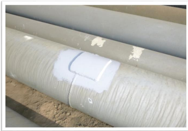
FIGURA 12: Aplicación de tintes penetrantes a todos los refuerzos soldados de Ø16.
