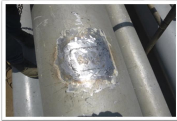
FIGURA 11: Esmerilado del refuerzo metálico.
