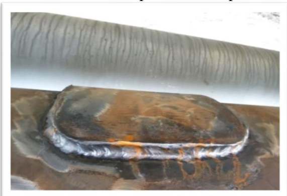
FIGURA 10: Soldeo perimetral de placa de refuerzo.
