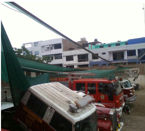
Figura 21: Patio de máquinas de la Compañía de Bomberos "Washington State" N° 177
