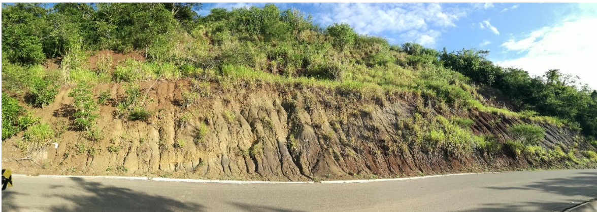
FOTO 02: En la imagen se puede apreciar una vista panorámica del estado en el que encuentra el lugar donde se desea construir el muro de contención.
