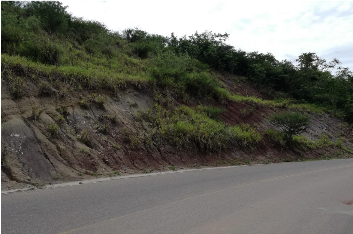
FOTO 01: Se observa en la imagen el reconocimiento de terreno de la cantera de donde será extraído la arcilla a ser realizado los ensayos correspondientes.
