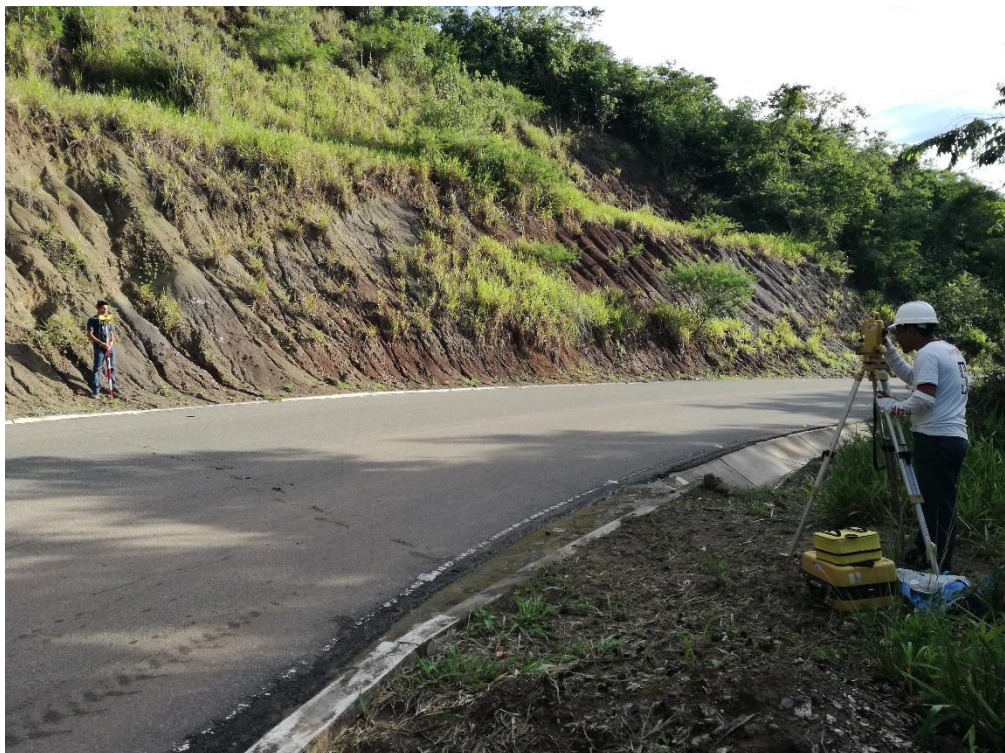
FOTO 04: Colocación de los distintos puntos del levantamiento topográfico.
