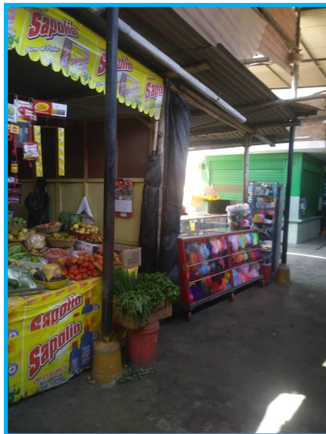
Figura 34. Fotografía de los soportes estructurales de algunos puestos de venta.
