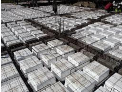
*Figura 7: Poliestireno en Construcción*
