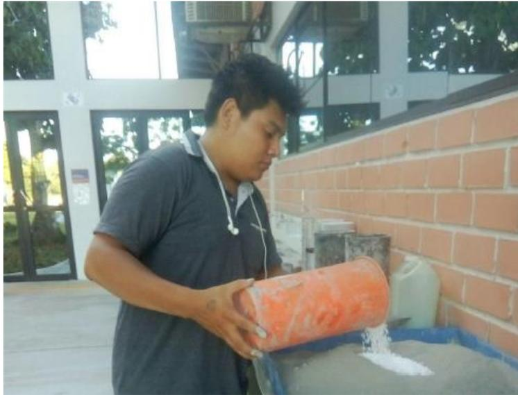
Fotografía 1: agregado del poliestireno a la mezcla
