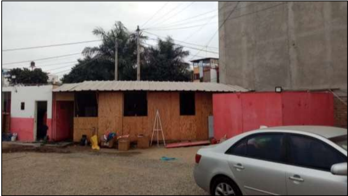
Imagen 04: Cocina - Comedor, en su exterior se aprecia que el espacio es utilizado como almacén de desperdicios, así como para acopio de materiales no compatibles con el funcionamiento de la cocina.
