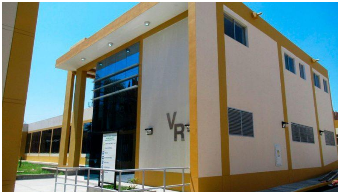
Figura 7. Nueva infraestructura del E.S. Víctor Raúl - Piura.
