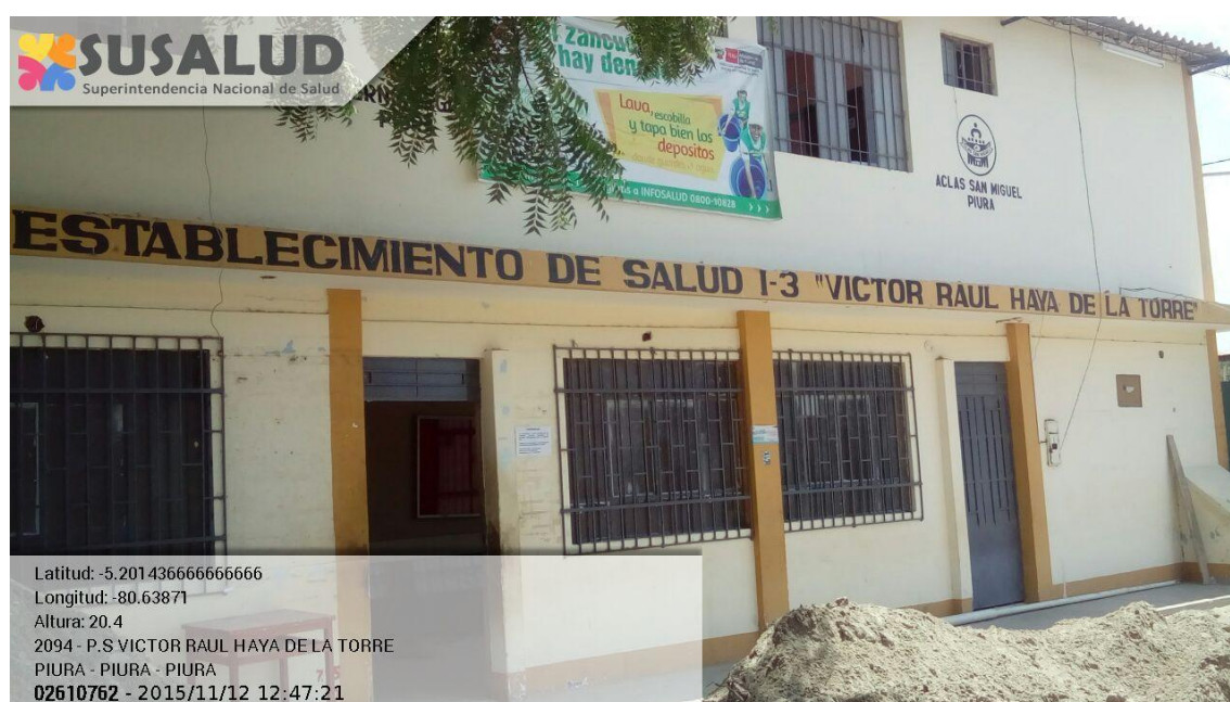
Figura 6. Infraestructura antigua del E.S. Víctor Raúl - Piura. Fuente: Susalud (2019).
