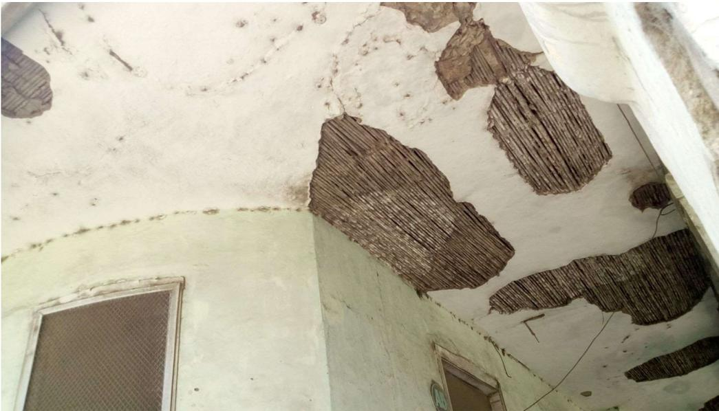
**IMAGEN DETALLE:** Estado de deterioro del techo del primer nivel de la galería principal del antiguo hospital de Casa Grande, por el desprendimiento del recubrimiento de barro, dejando a la vista el entramado de quincha que presenta su techo. [Fuente: Fotografía propia]
