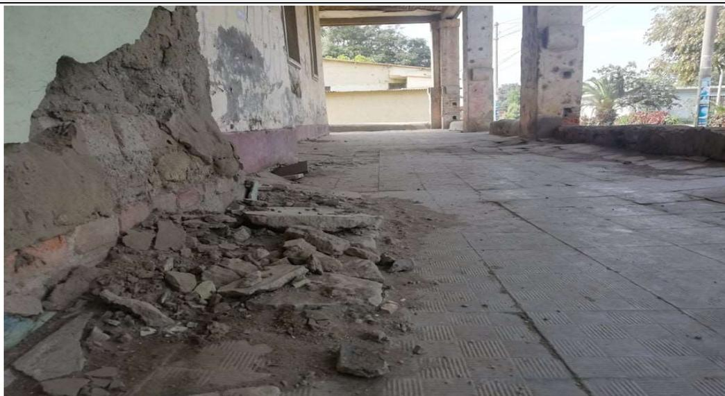
**IMAGEN DETALLE:** Estado de deterioro de los muros del primer nivel de la galería principal del antiguo hospital de Casa Grande, por el desprendimiento del recubrimiento de barro, además del desnivelado del piso y resquebrajadura de las algunas paredes, producto de la falta de mantenimiento al inmueble. [Fuente: Fotografía propia]
