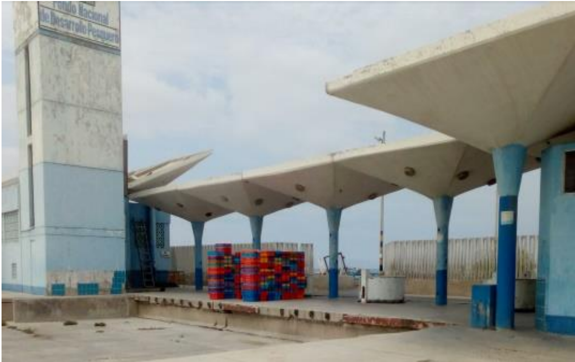
Figura 32: Cobertura área de lavado DPA Las Delicias
