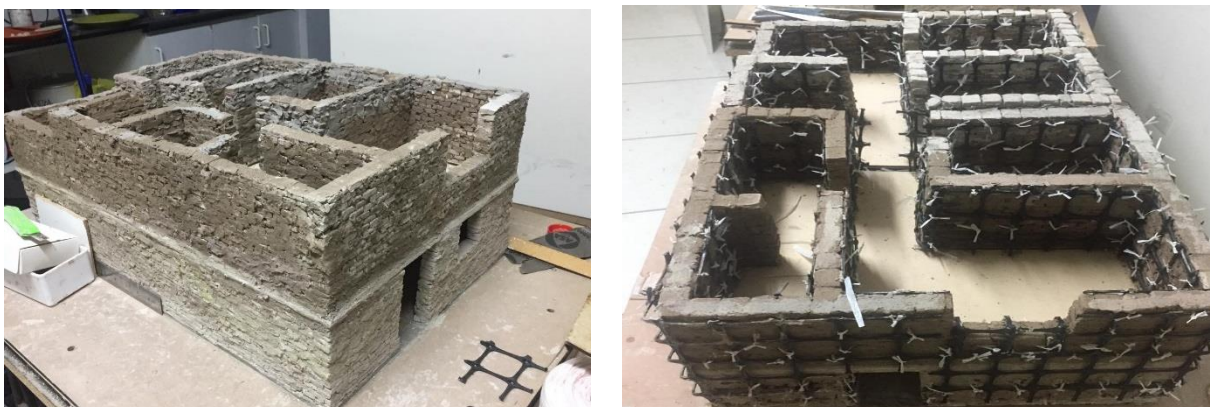
Figura 47. Asentado de adobes y colocación de geomalla. Fuente: Imagen propia, 2019
