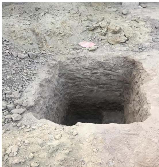
Figura 33. Calicata realizada en el terreno. Fuente: Imagen propia, 2019
