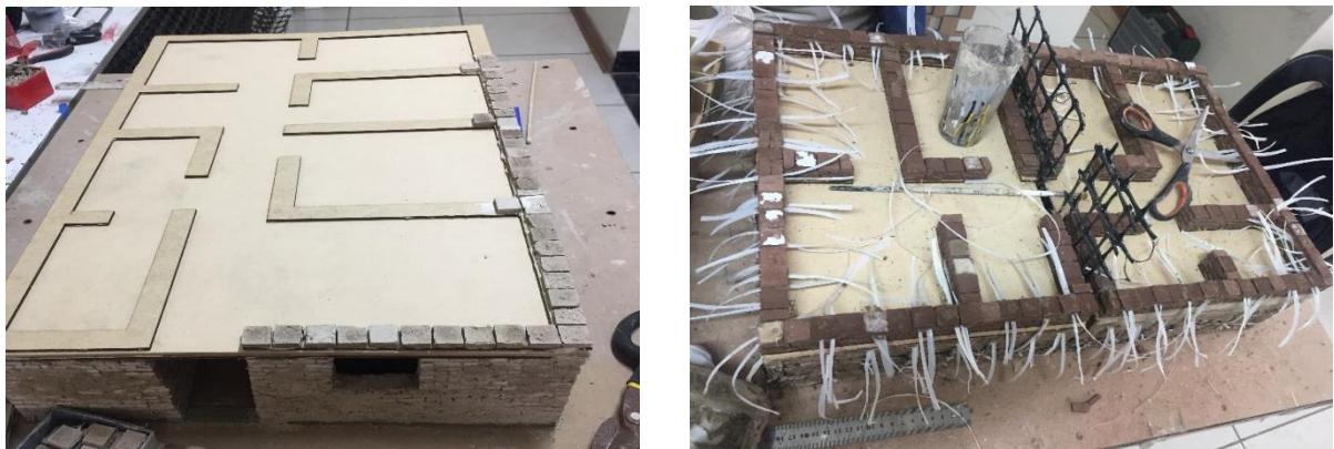
Figura 46. Asentado de bloques, nivel 2. Fuente: Imagen propia, 2019
