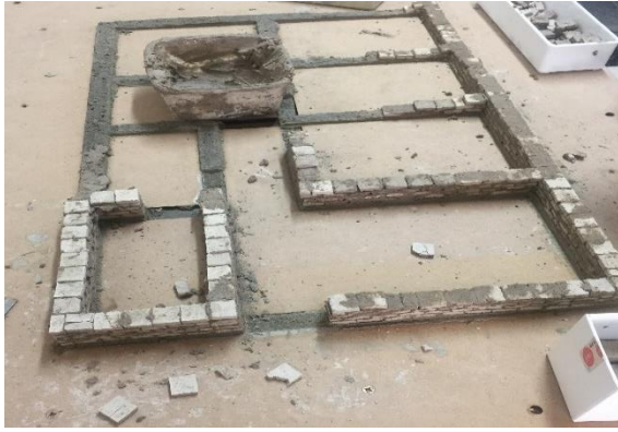
Figura 42. Asentado de bloques. Fuente: Imagen propia, 2019
