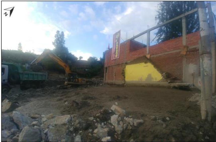
Fotografía 4: Vivienda colapsada por arrastre de material del huayco.
