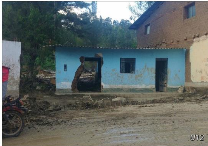
Fotografía 5: Material transportado por el huayco afecta vivienda, dejándola en condición de inhabitable.
