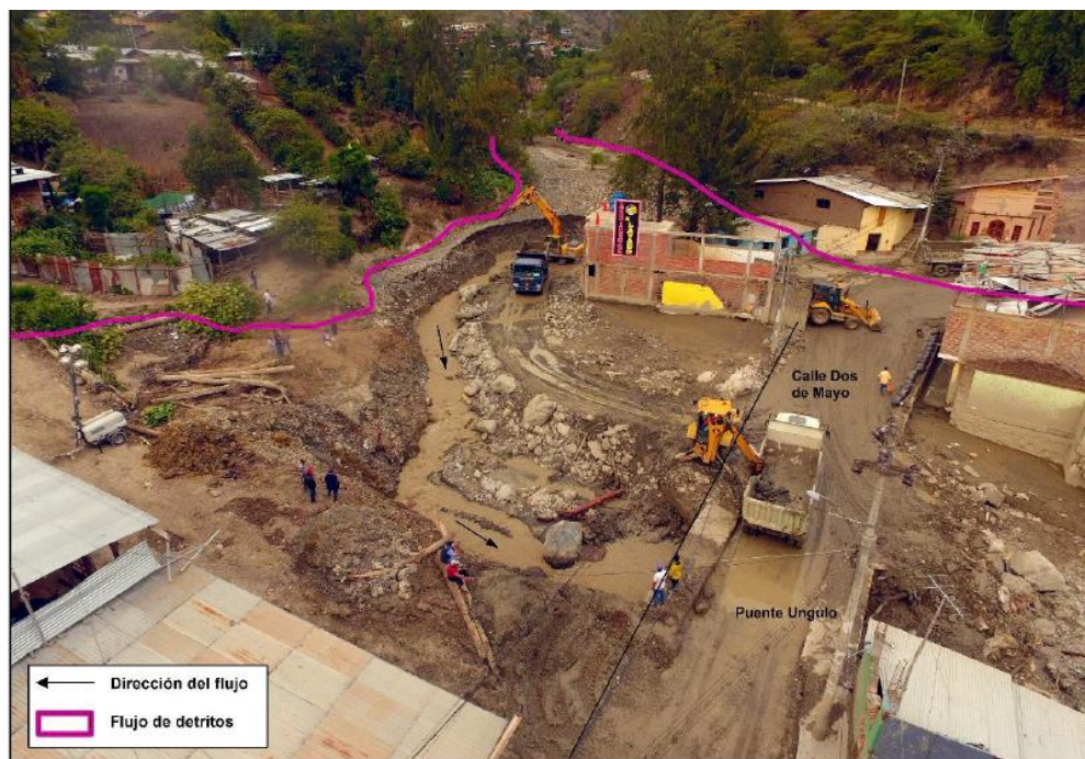
Figura 3: Vista de las viviendas ubicadas en el cauce de la quebrada Ungulo y en las márgenes del mismo que han sido gravemente afectadas por el huaico.
