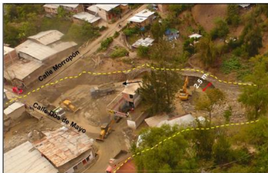
Figura 15: Vista de la quebrada Ungulo desde la ciudad de Huancabamba. Nótese que en esta zona el flujo de detritos alcanzó 2.5 metros de altura.
