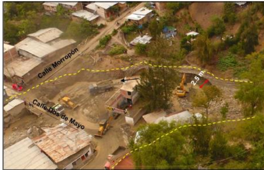
Figura 15: Vista de la quebrada Ungulo desde la ciudad de Huancabamba. Nótese que en esta zona el flujo de detritos alcanzó 2.5 metros de altura.
