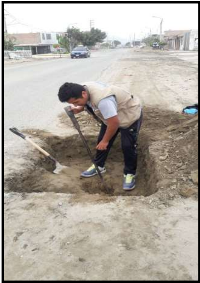
Descripción: Elaboración de Calicata 01 en campo
