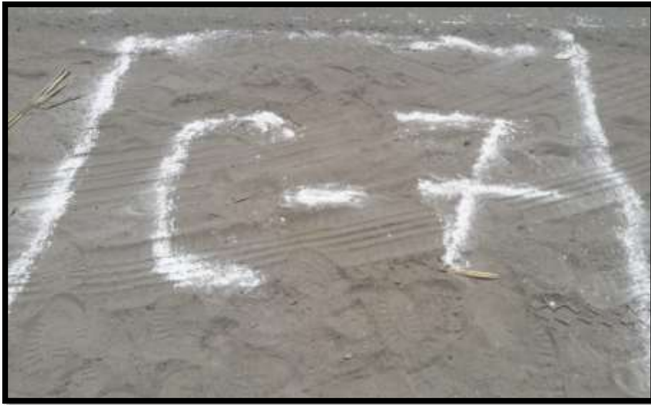
Descripción: Elaboración de Calicata 07 en campo
