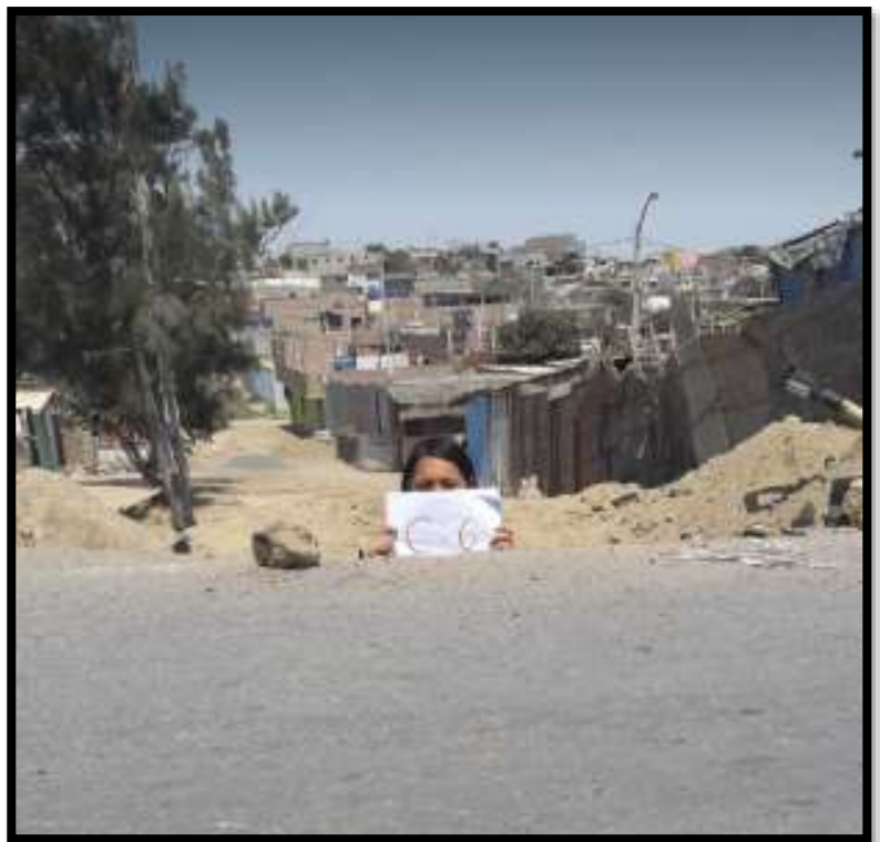
Descripción: Elaboración de Calicata 06 en campo
