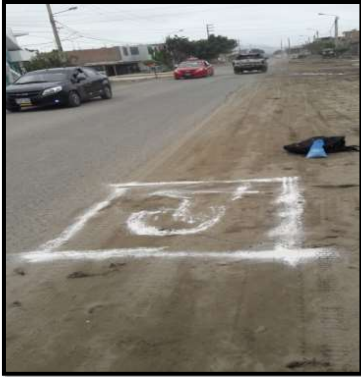
Descripción: Elaboración de Calicata 01 en campo
