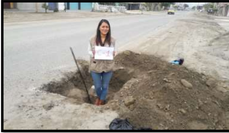
Descripción: Elaboración de Calicata 01 en campo
