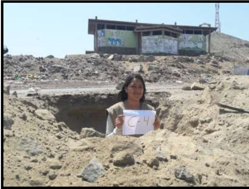
Descripción: Elaboración de Calicata 04 en campo
