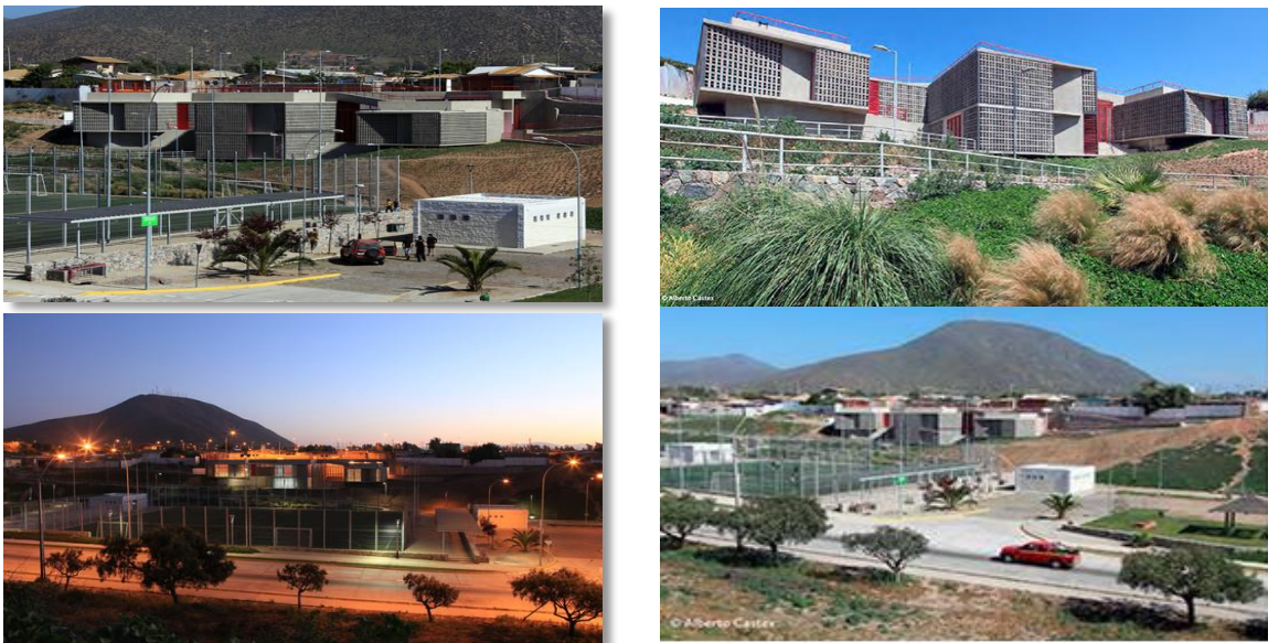
Figura 53 : Fachadas del Centro Comunitario La Sierra –Chile
