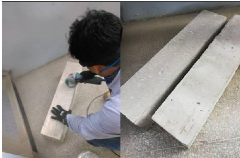
Figura 51. Desencofrado de las vigas
