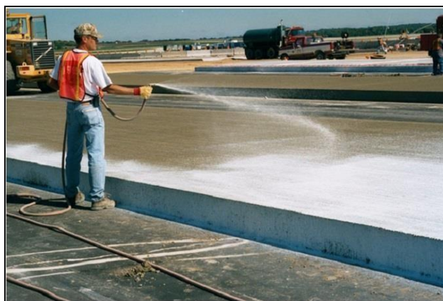
Figura 6. Protección y Curado del concreto
