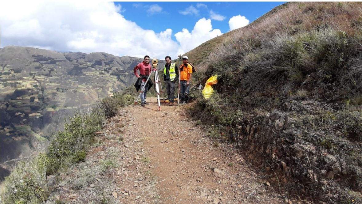
FOTO 02: Realizando levantamiento topográfico
