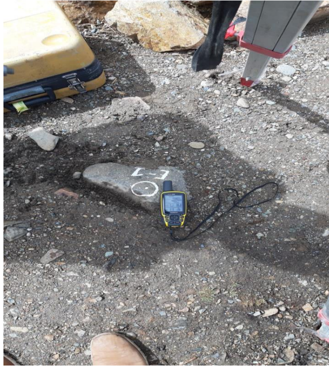
FOTO 01: Inicio del levantamiento topográfico
