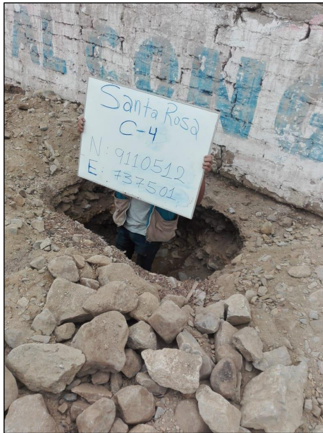
Figura 26 : Calicata N°04 para el estudio de suelos
