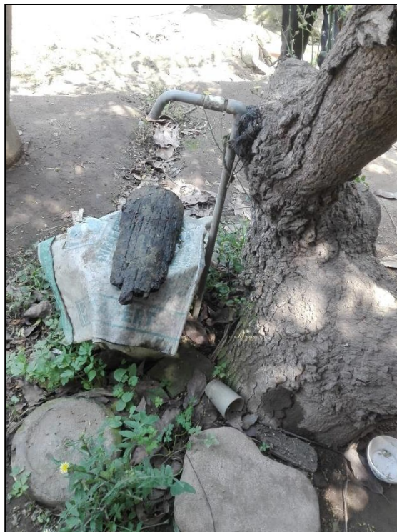
Figura 31 : Conexión existente en la casa ubicada en la parte más baja de Santa Rosa.
