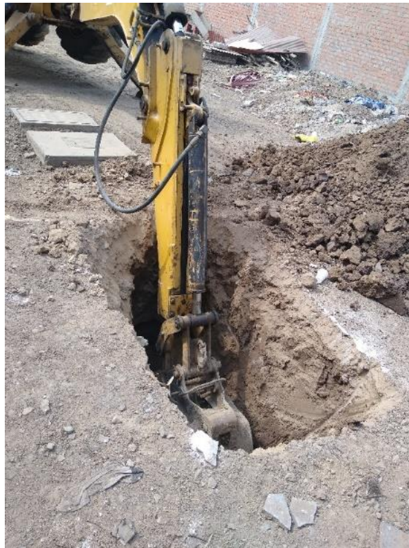
Excavación de la calicata C-1.
