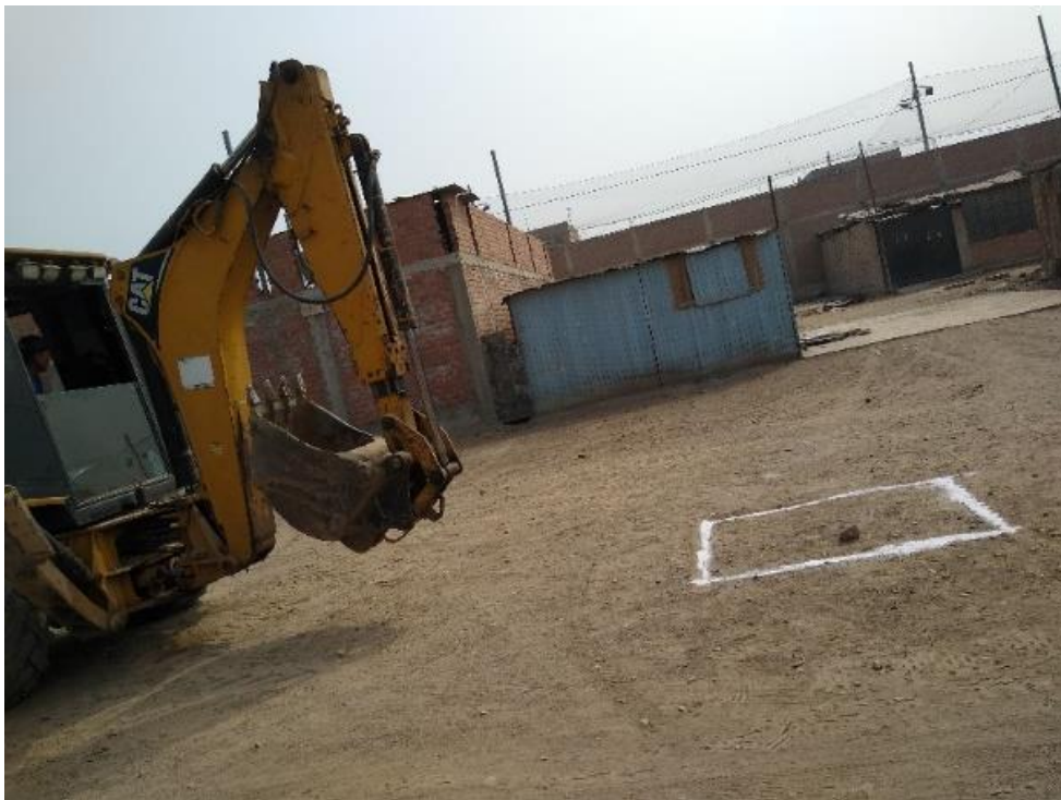
Posición de la maquinaria en la calicata C-2
