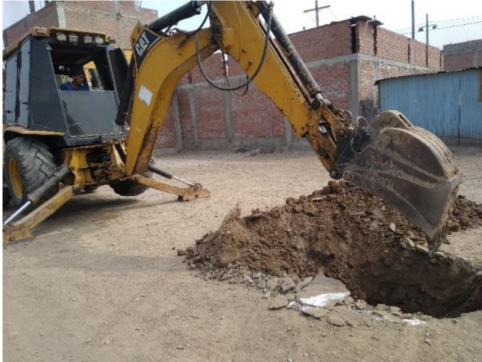
Excavación de la calicata C-2
