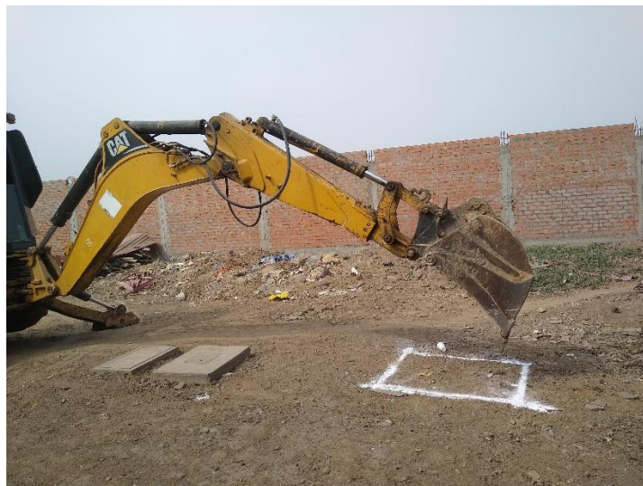
Figura 5: Vista de la ejecución de la C-1
