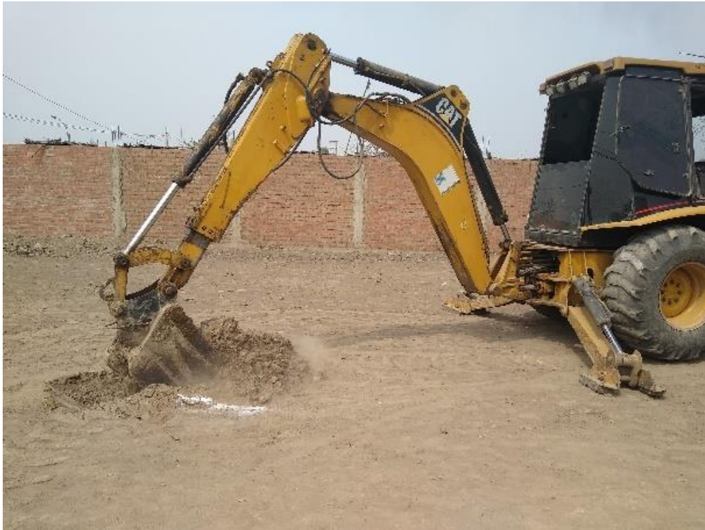
Posición de la maquinaria en la calicata C-3
