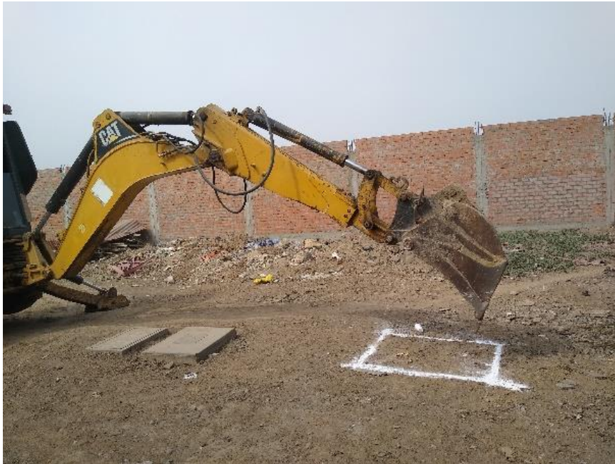
Posición de la maquinaria en la calicata C-1.
