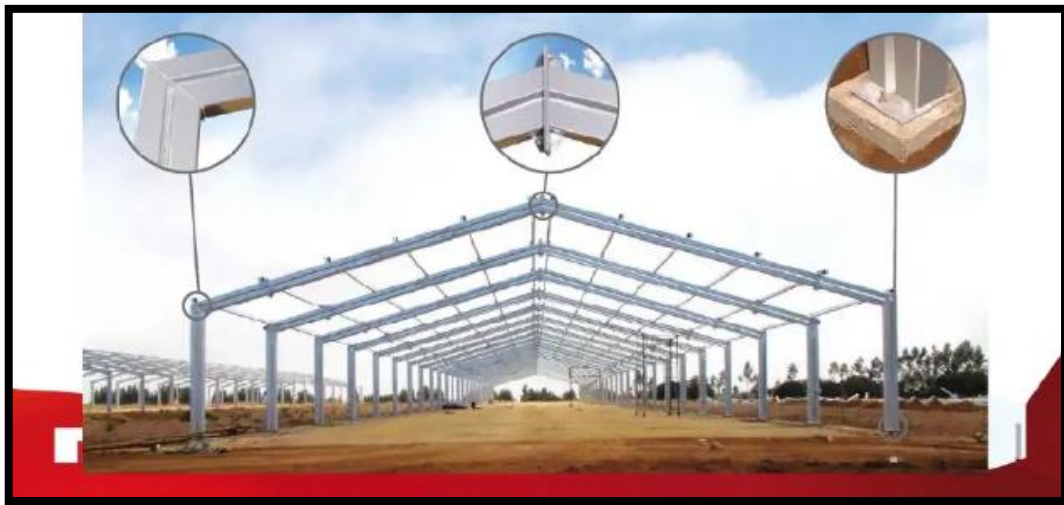
Figura 04. Sección de perfil Ohm Fuente: TUPEMESA (2016)
