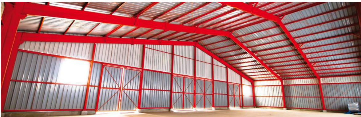
Figura 21. Nave industrial con sistema metálico Tubest (Autosoportante)
