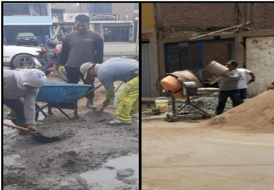
*Figura 7.* Elaboración de concreto hecho en obra de manera manual y con maquinaria
