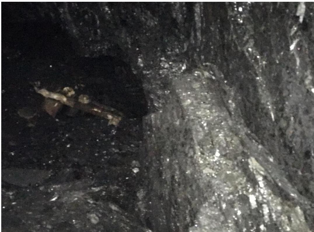
*Figura 24:* Sistema de sostenimiento deficiente en la galería principal del nivel 2650.
