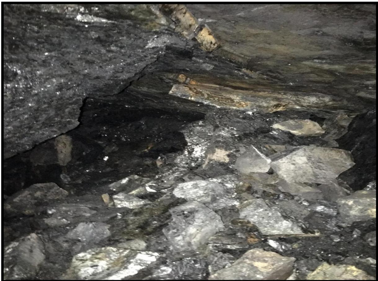
*Figura 8:* Situación actual de sostenimiento en la galería principal del nivel 2650.
