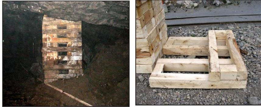
*Figura 5: Forma correcta de un Wood Packs.*
