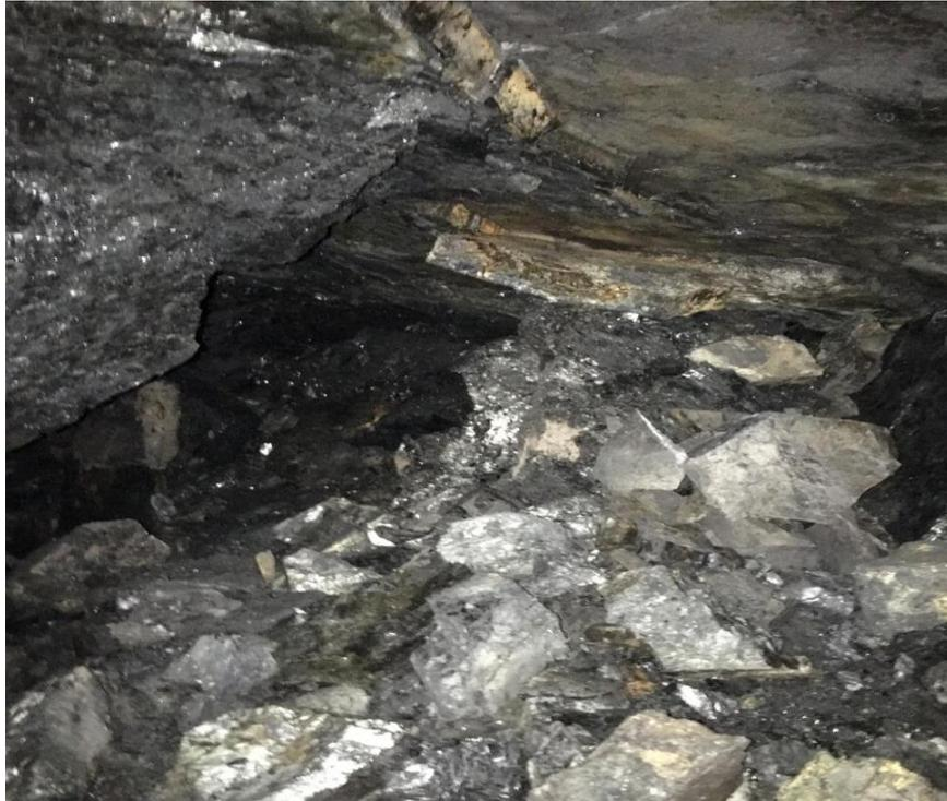
*Figura 17:* Desprendimiento del macizo rocoso en la galería principal del nivel 2650.
