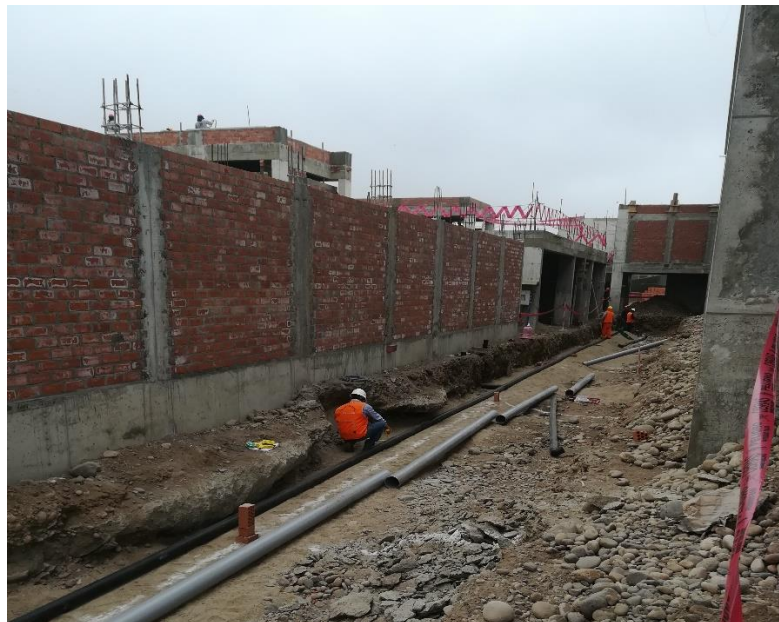
Fotografía 2. Supervisión observando las tuberías HDPE en el proyecto Mercado de Chancay. (Fuente: Tomado por parte propia).
