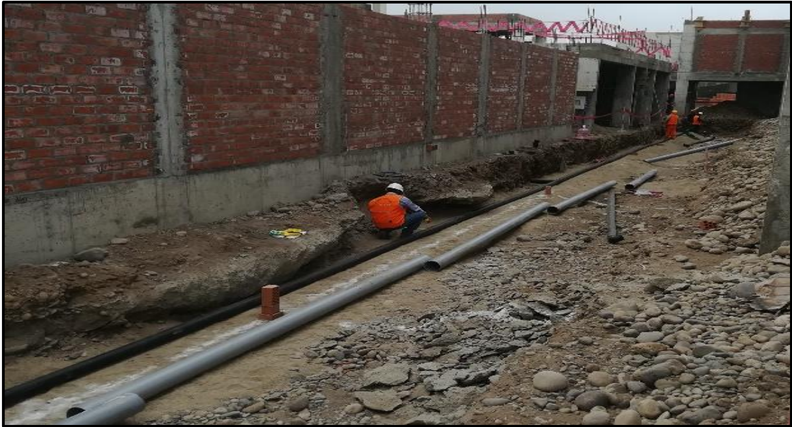
Figura 1. Instalación de la tubería HDPE en la nave central del mercado de Chancay. (Fuente: Tomada por parte propia).
