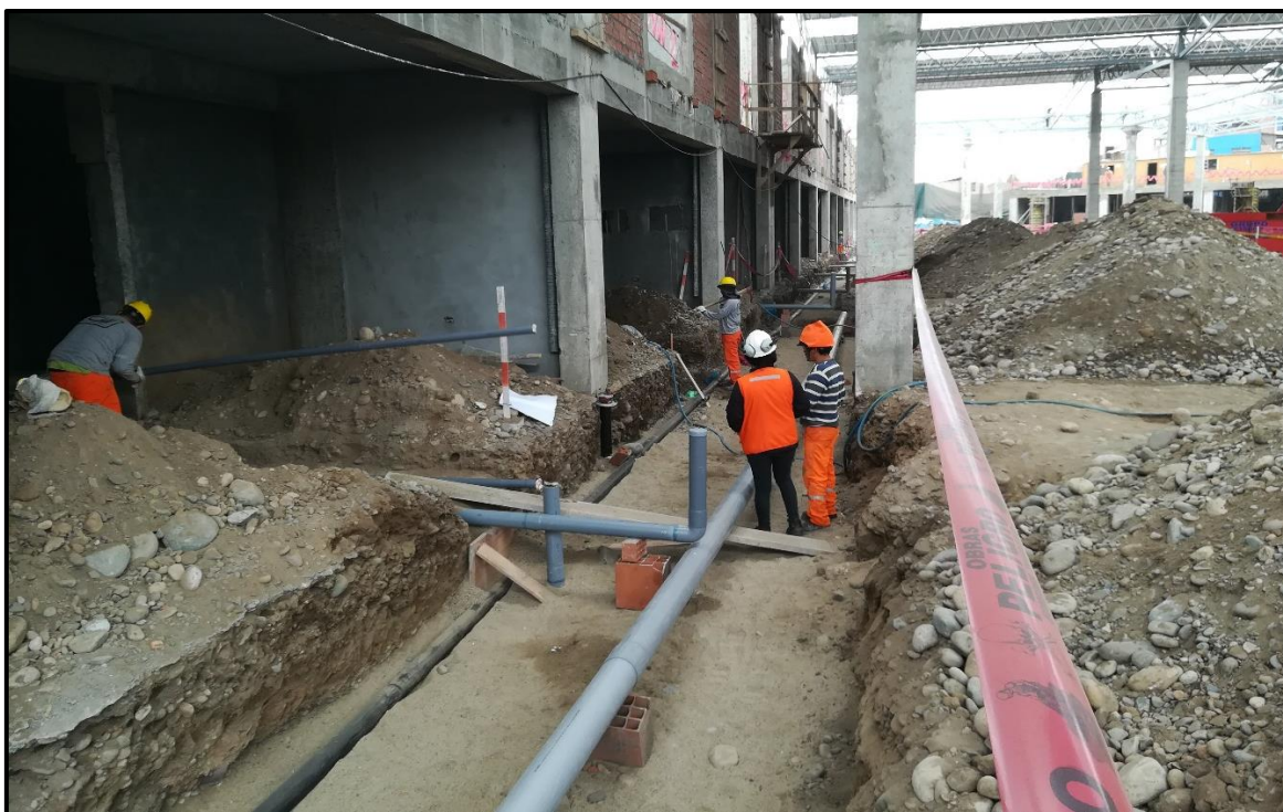
Figura 22. Instalación de la tubería HDPE con supervisión de la especialista del proveedor PYDE. (Fuente: Tomada por parte propia).
