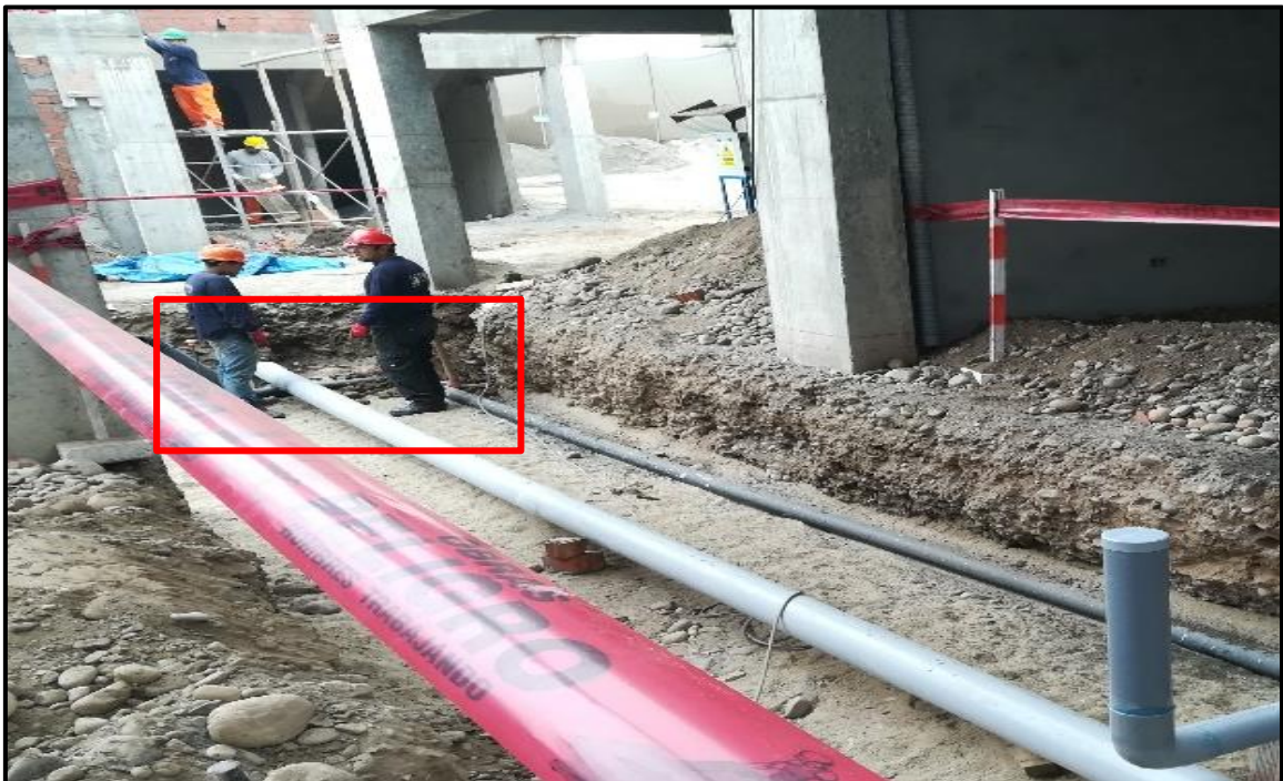
Figura 2. Montaje de la tubería HDPE e interferencias de especialidades en la nave central del mercado de Chancay. (Fuente: Tomada por parte propia).
