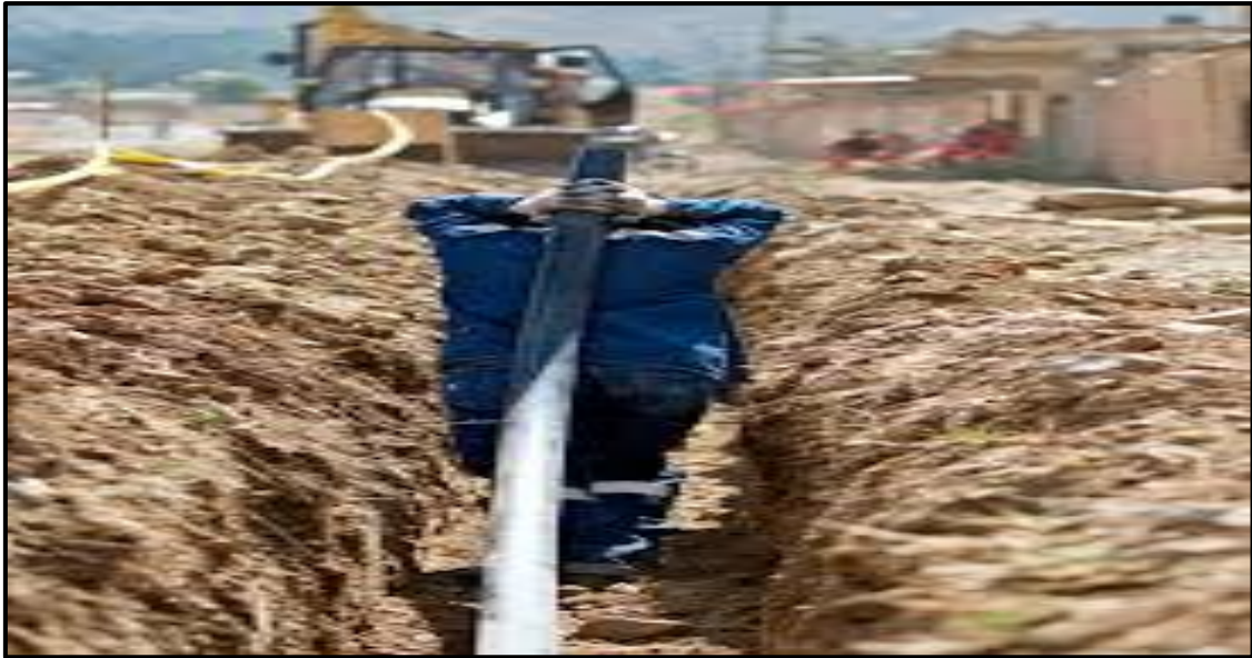
Figura 100. Montaje de la tubería HDPE en zanja. (Fuente: Plastiforte).
