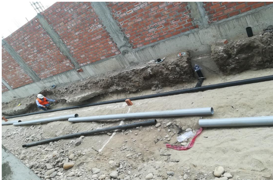
Figura 31. Medición de tubería HDPE en el Proyecto Mercado de Chancay. (Fuente: Tomada por parte propia).
